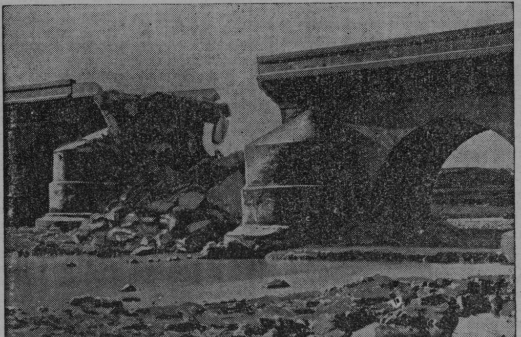
Tako zgleda od rdečih na španskem raz streljeni most.
