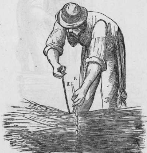
Fig. 85.—Acto de pasar la aguja el obrero por la lazada del extremo opuesto del ramal.
