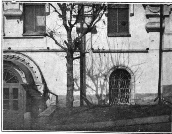
FIG. 18. Fenêtre grillée de la chambre du meurtre.
