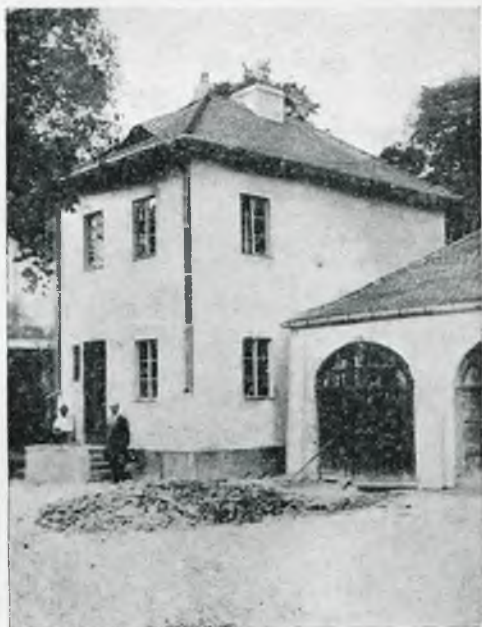
Dom stalowy syst. Böhlera, zbudowany przez Min. Robót Publ. w Warszawie, przy ul. Se- natorskiej, obok pałacu Dekerta.
