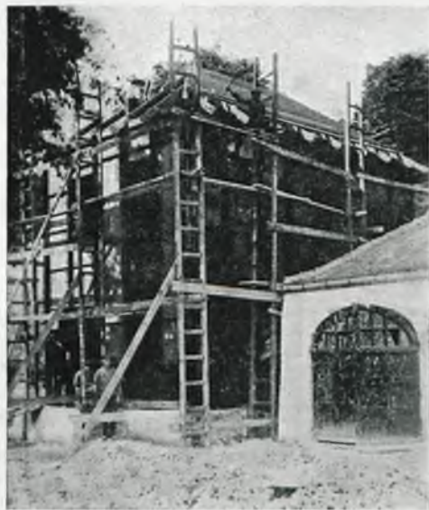
Dom stalowy syst. Böhlera, zbudowany przez Min. Robót Publ. w Warszawie, przy ul. Se- natorskiej, obok pałacu Dekerta. rys. 2.
