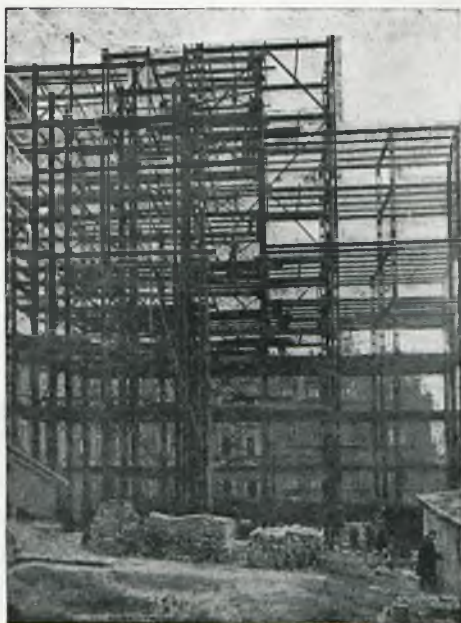
Szkielet domu prof. szkół zawodowych, zbudowany przez Śl. Urząd Wojewódzki w Katowicach, przy ul. Wojewódzkiej. rys. 1.
