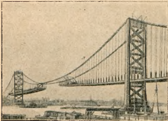
Rys. 55. Początek powrotnego ruchu dźwignika montażowego ku filarowi.
