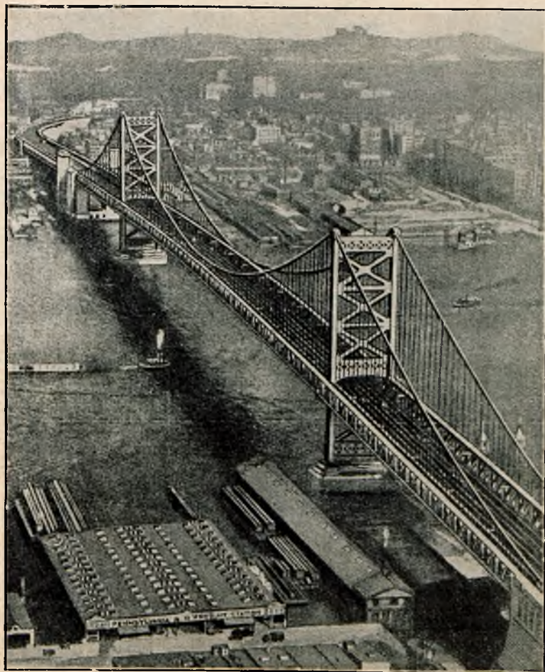
Rys. 6. Widok perspektywiczny mostu Filadelfijskiego po ukończeniu montażu jezdni.
