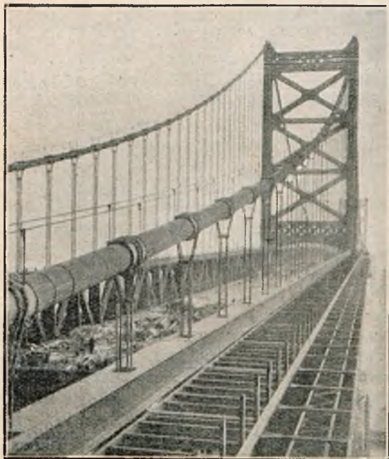
Rys. 21. Widok połączenia wieszaków z linami głównymi.
