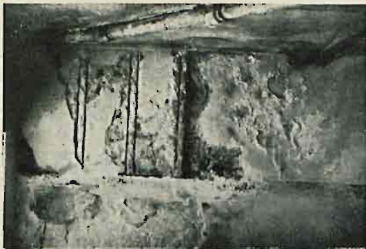
rys. 261 (Warszawa). Zawilgocenie sufitu przez nieszczelność posadzki terrakottowej na wyższym piętrze
