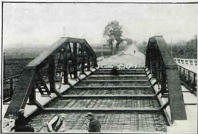
FIG. 24. — Achèvement du tablier du pont.
