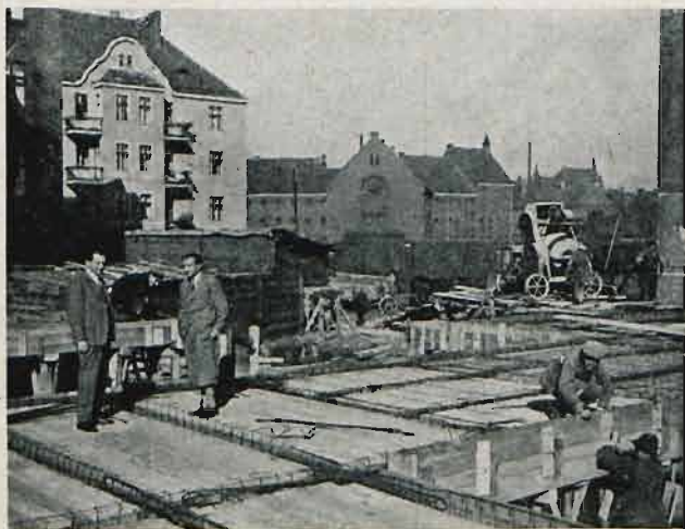
Zbrojenie stropu suterren górnych.
