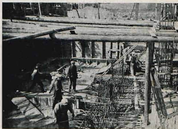
Betonowanie płyty fundamentowej.
