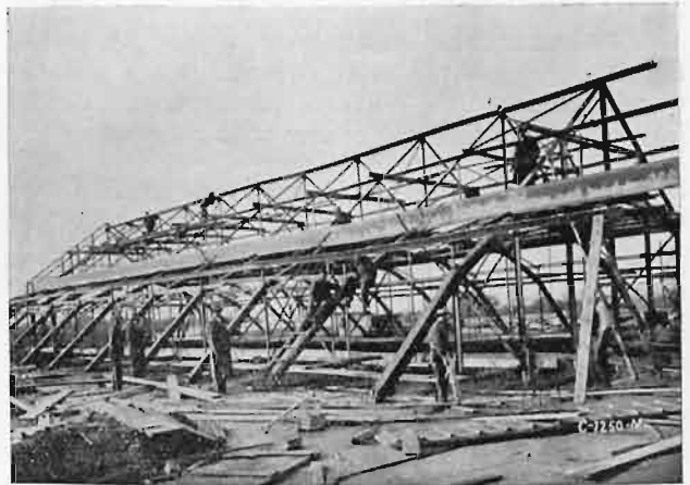
Rys. 7. Więzary dachowe w czasie montażu.
