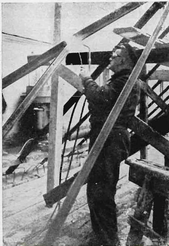
Wykonywanie świetlaka w Domu Powszechnego Zakładu Ubezpieczeń Wzajemnych w Warszawie, przy pomocy palnika tlenowo acetylenowego
