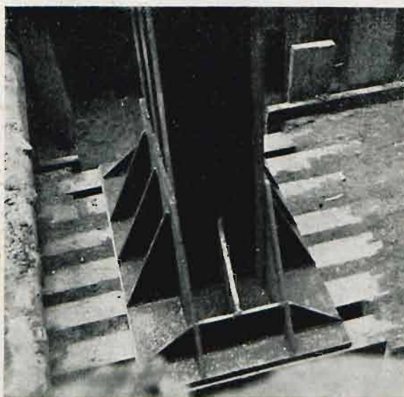
Podstawa słupa spawanego budynku P. K. O. w Warszawie
