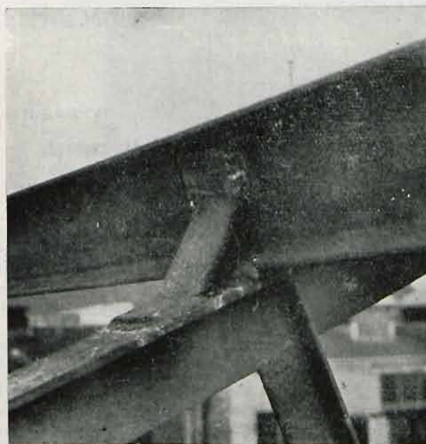
Rys. 10. Umocowanie płatwi na więzarach.
