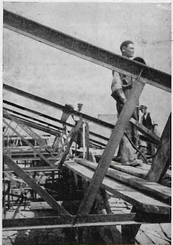
Rys. 5. Połączenie wpustowe pomiędzy słupkami i pasami.
