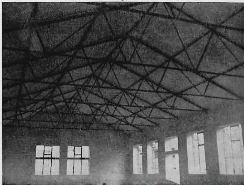
Rys. 2. Widok na całość konstrukcji dachowej po wykonaniu.
