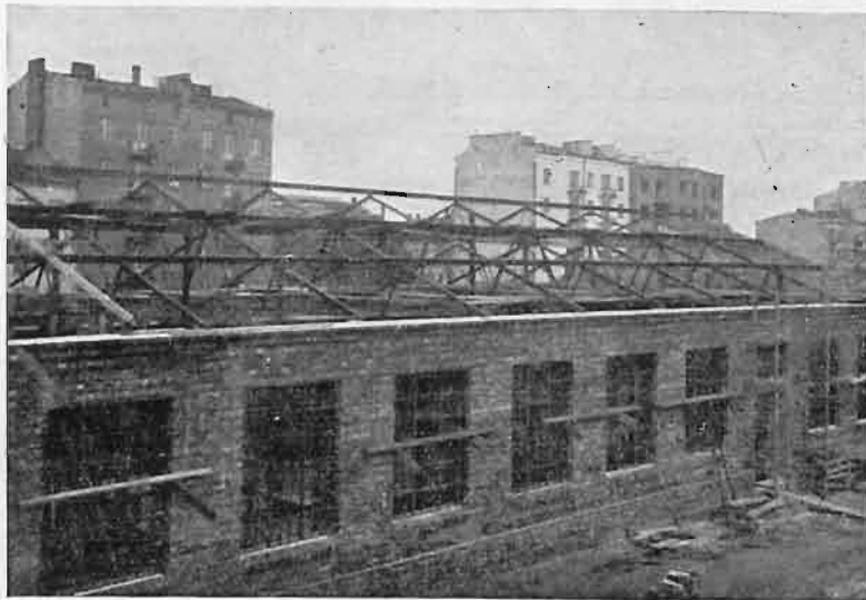
Rys. 1. Widok dachu podczas budowy.
