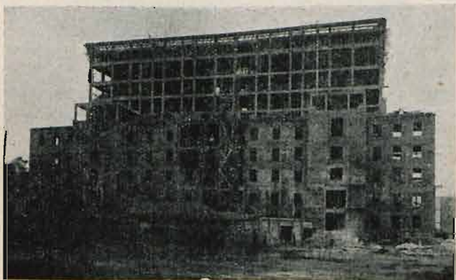
Fig. 6. Budowa Domu Akademickiego w Warszawie.
