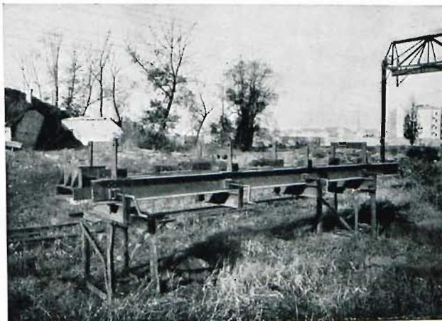
**Fig. 719.** Assemblage des poteaux métalliques par soudure.
