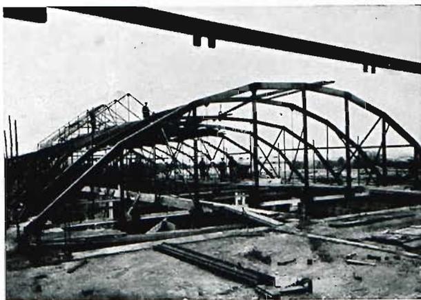
**Fig. 717.** Charpente de la toiture au-dessus de la salle de lecture.
