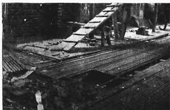
Rys. 29. Ułożenie rur z przewodnikami pod podłogą sali operacyjnej.
