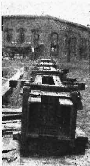
Rys. 23. Jarzma montażowe słupów.
