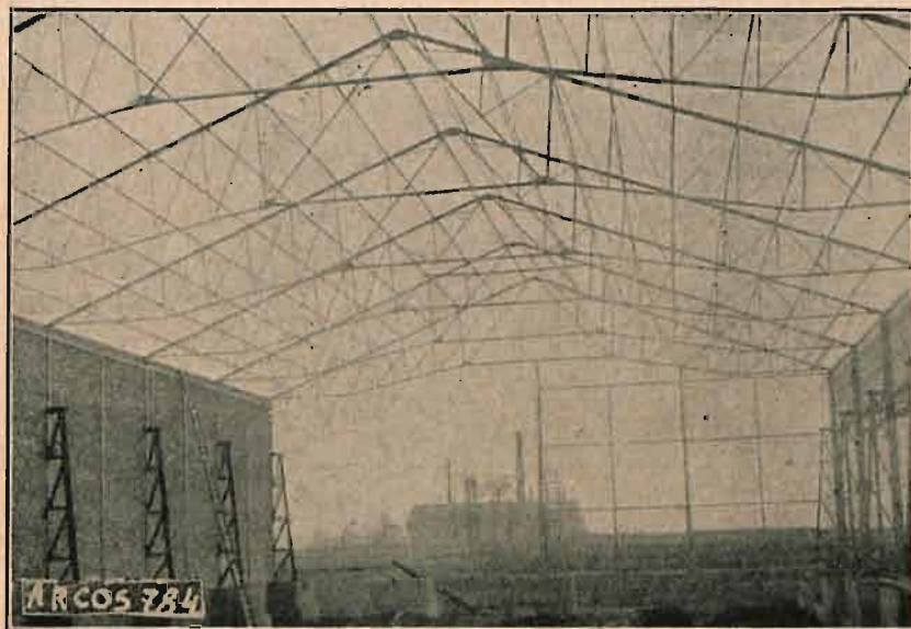
Rys. 10. Budynek spawany, rozpiętości 20 m.
