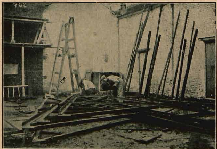
Rys. 15. Spawanie części konstrukcji dachowej na miejscu budowy.
