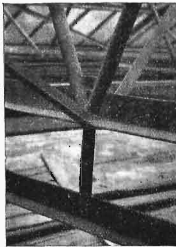
Rys. 15. Podwieszenie sufitu.
