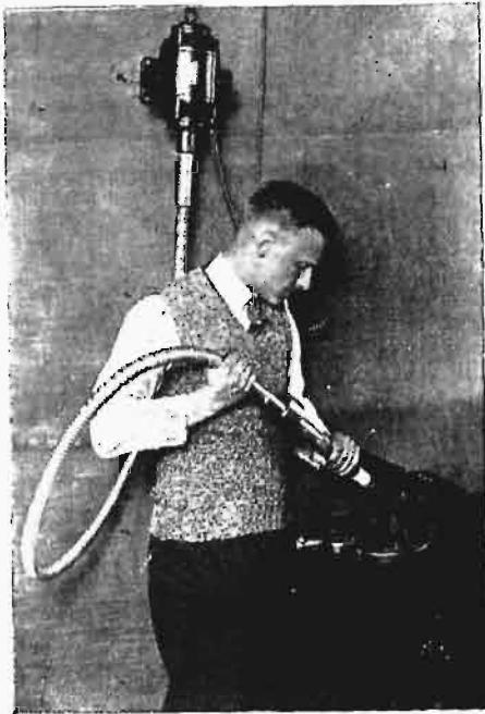
Rys. 20. Przyrząd do wydrążania spoin.
