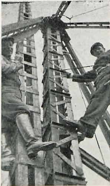
Rys. 6. Żóraw-derrick spawany.
