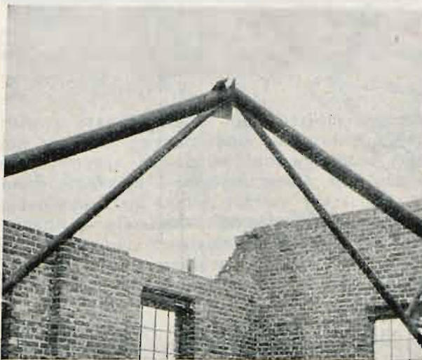
Rys. 12. Węzeł górny więzara przed spawaniem.
