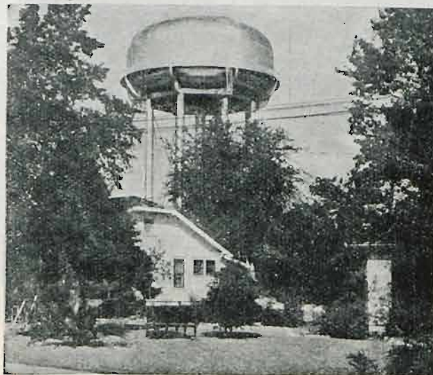
Rys. 16. Zbiornik na wodę w Talahassu, spoczywa na 8 słupach rurowych spawanych.
