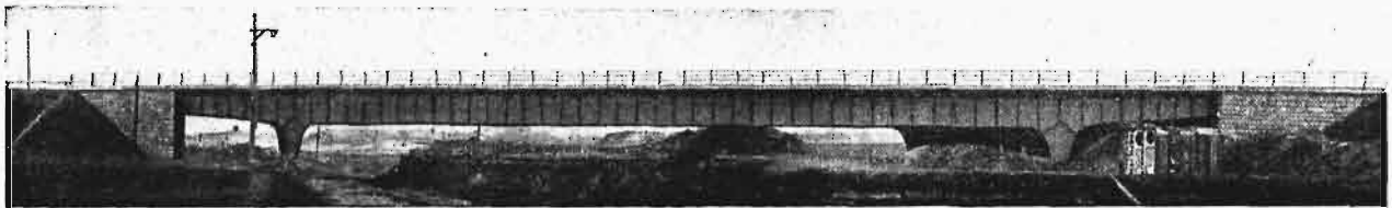
Rys. 16. Most nad kanałem Elstera-Saafa.
