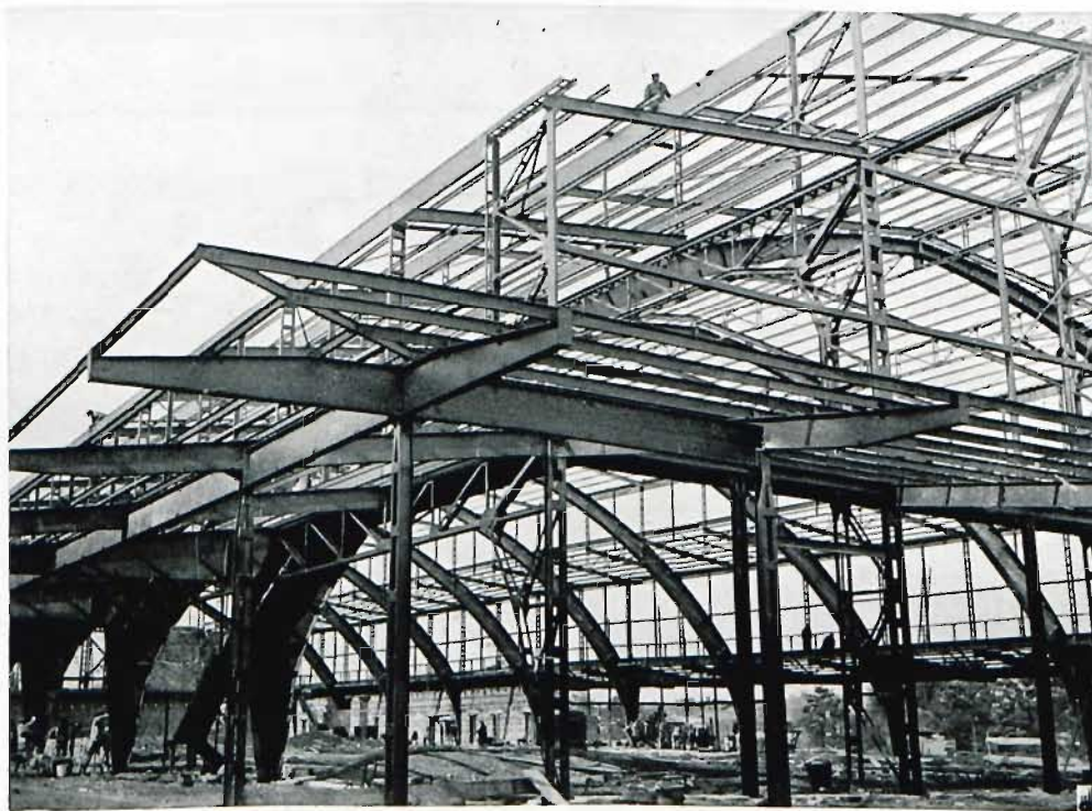
Fig. 596. Vue de l'ossature métallique en voie d'achèvement. A gauche, on aperçoit les parties en porte-à-faux de l'ossature constituant l'auvent.
