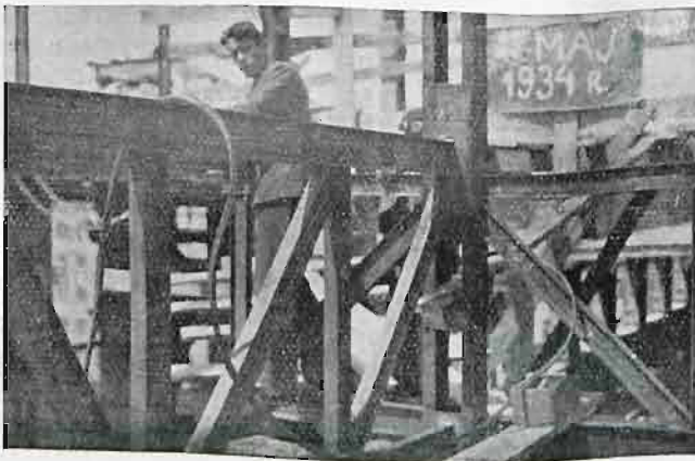
Rys. 10. Podciągi kratowe.
