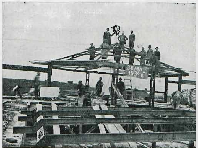
Rys. 12. Krokwie dachowe i świetlik.
