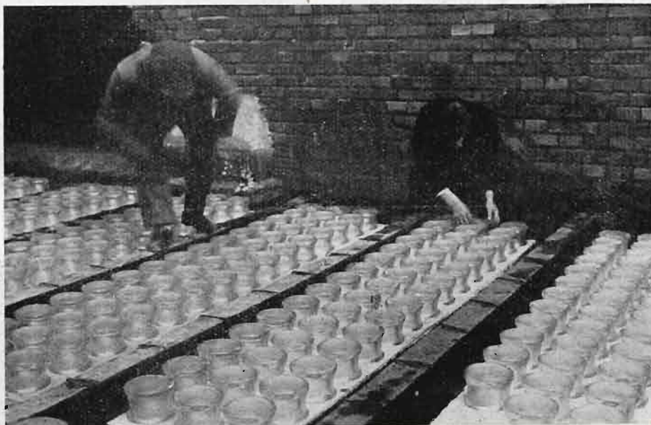
Fig. 23. Układanie przyzm szklanych stropu piwnicznego pod podwórzem w Centr. Telegr. i Telef.
