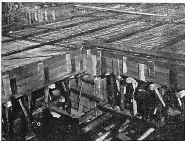
Fig. 17. Strop suterren „drapacza” w Katowicach.
