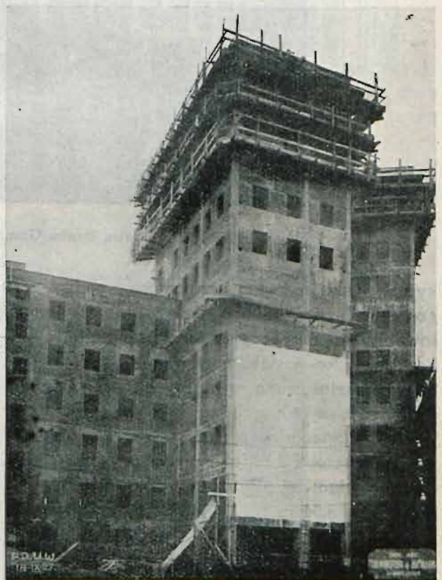
Fig. 6. Budowa Gmachu Powszechnego Zakładu Ubezpieczeń Wzajemnych w Warszawie.
