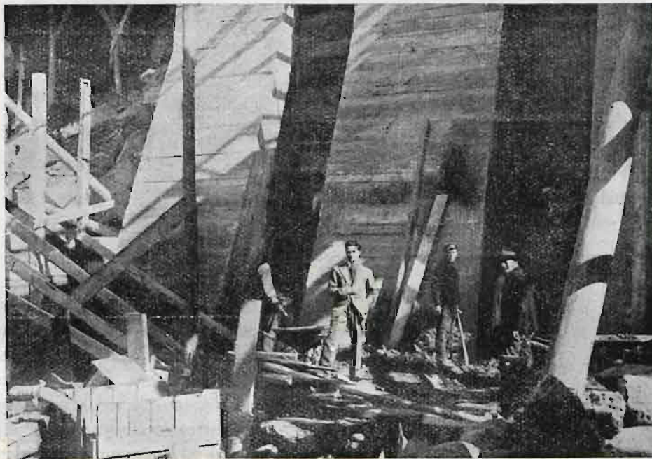
Fig. 21. Mur oporowy Centr. Teleg. i Telef. w Warszawie.
