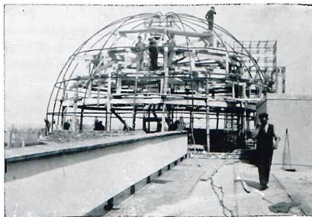
Fig. 18. Coupole en tubes soudés de la Caisse d'Épargne de Varsovie.
