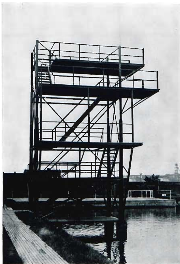
Fig. 14. Plongeoir en tubes soudés, à Szarłoj, Pologne.
