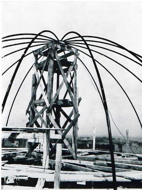
Fig. 19. La coupole en tubes soudés de la Caisse d'Épargne de Varsovie en cours d'exécution.
