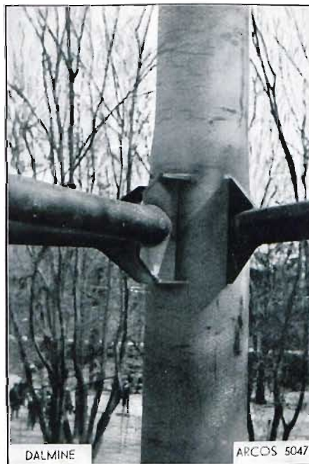
Fig. 25. Détail d'un des six nœuds d'angle d'un contreventement horizontal de la Tour Littoria à Milan. (Cliché Arcos.)
