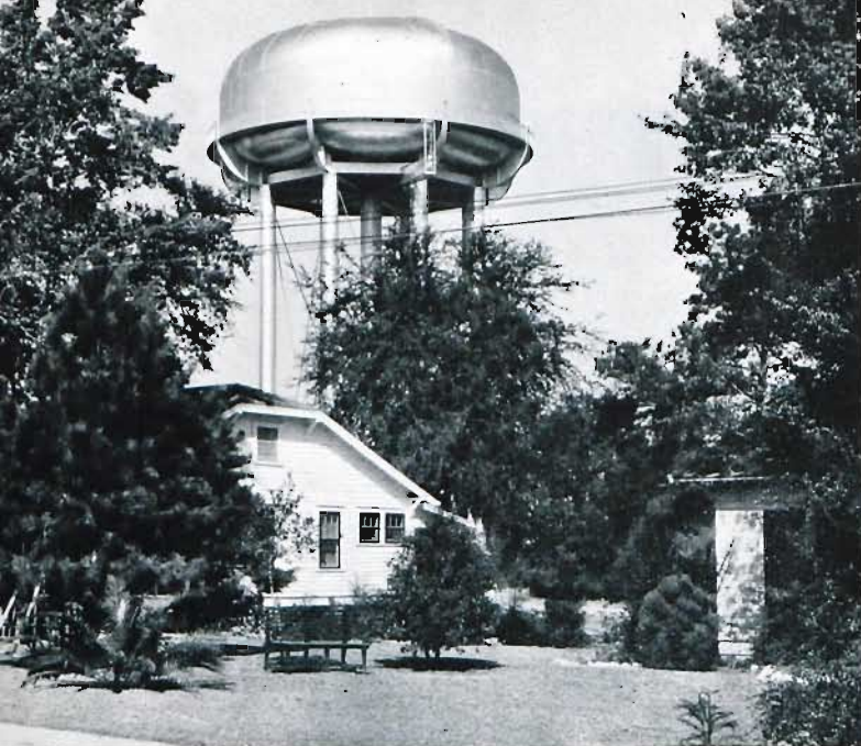
Fig. 24. Château d'eau à Tallahassee, Floride. Capacité 1.515 m 3 . Le réservoir est supporté par 8 piliers tubulaires.
