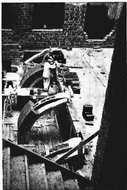
Rys. 2. Szczegół wykonania stropu nad podziemiem.
