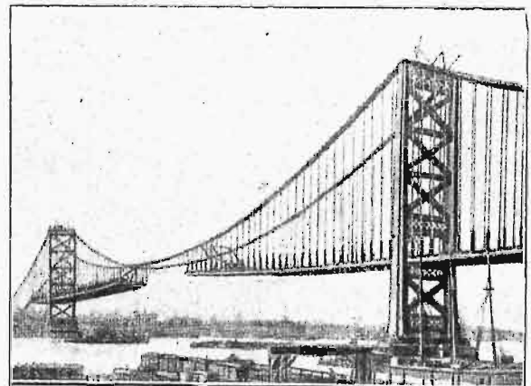
Rys. 55. Początek powrotnego ruchu dźwignika montażowego ku filarowi.
