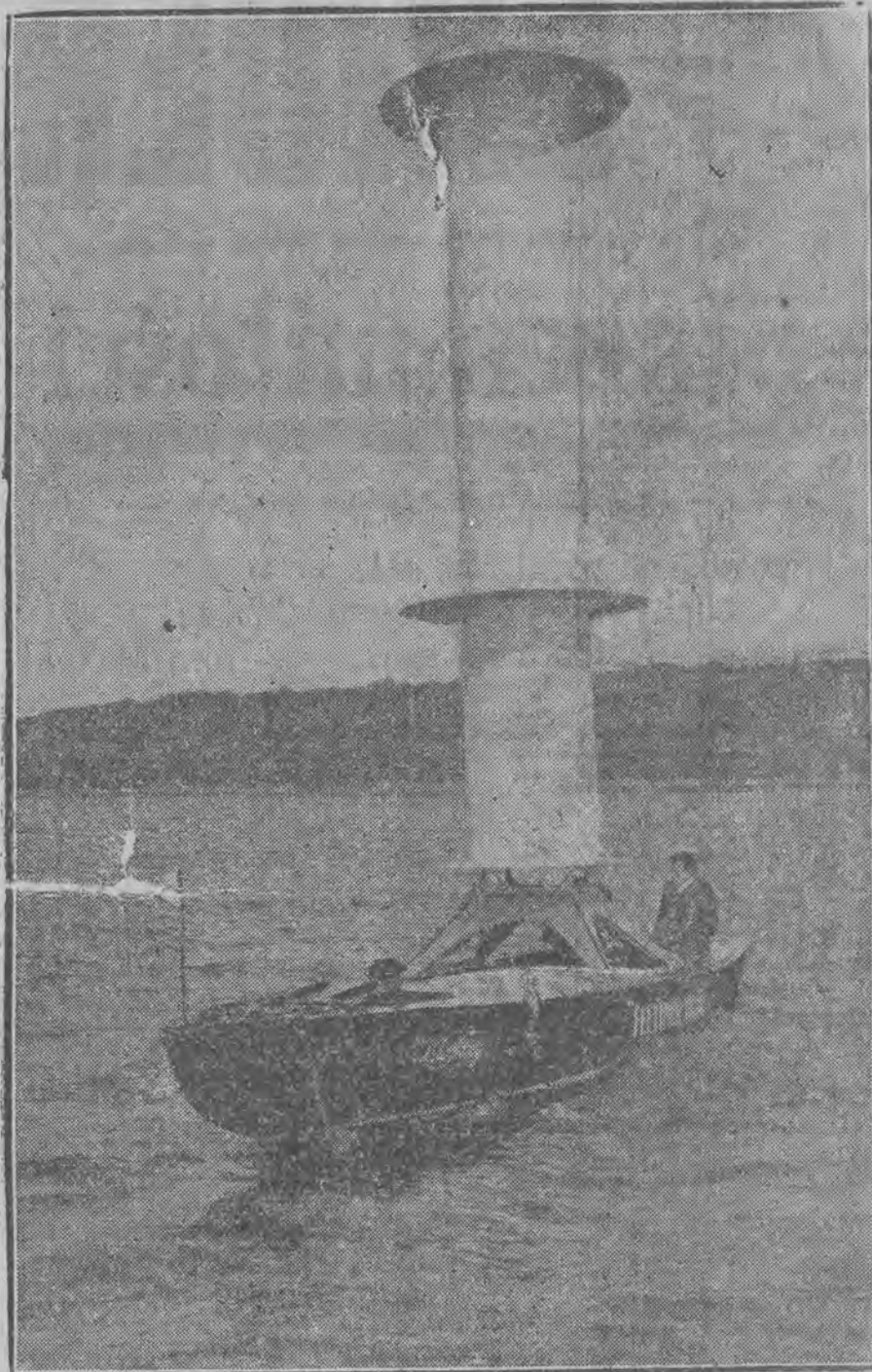
Lodzie rotorowe Flettnera, stanowiące przewrót w żegludze.
