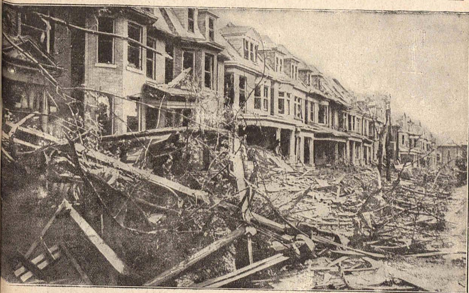
Ulica w Saint Louis po przejściu huraganu, który szalał w rejonie rzeki Missuri.
