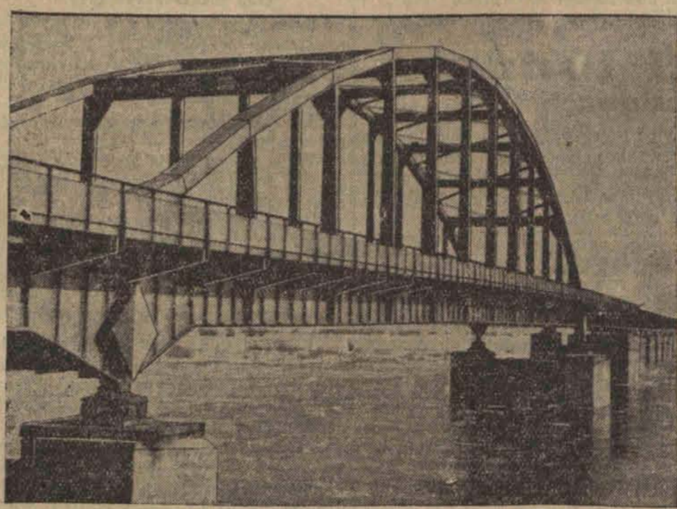
Przez Łabę zbudowano nowy most o kom binowanej konstrukcji żelazno - betonowej. Most spoczywa również na betonowych filarach i ma przeszło kilometr długości.
