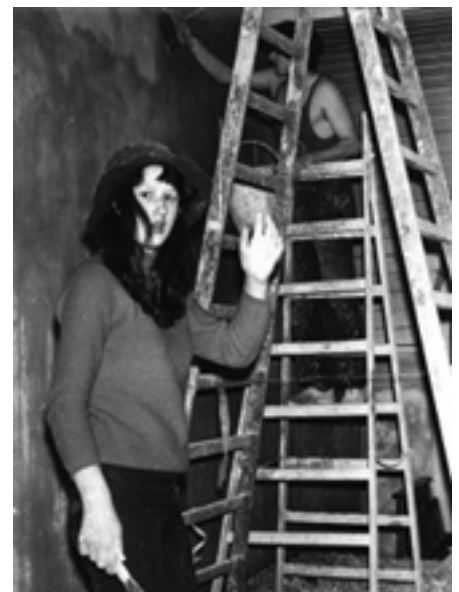
Rys. 6. Remont audytorium w 1972 roku
