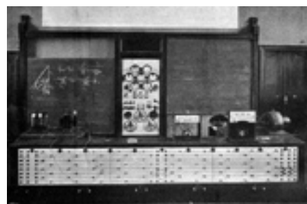
Rys. 2. Przednia ściana audytorium w 1909 roku
