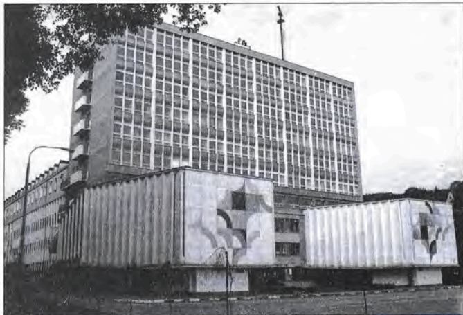
Budynek Wydziału Oceanotechniki i Okrętownictwa (fot. B. Urbanowicz)
