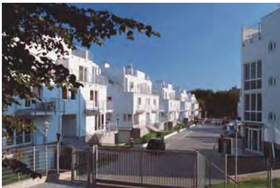
il. 1. Osiedle „Nad potokiem” w Gdyni Orłowie – realizacja 2002 r
