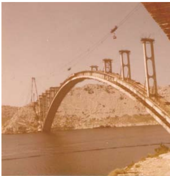
Budowa mostu Kopro-Krk koło Rijeki, wrzesień 1981 rok Fot. Archiwum autora
