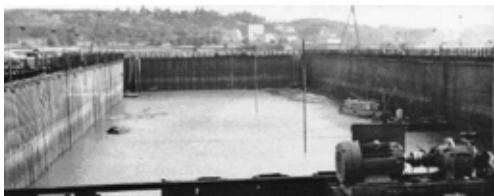
Widok zagłębienia doku po częściowym odpompowaniu wody Fot. Archiwum autora
