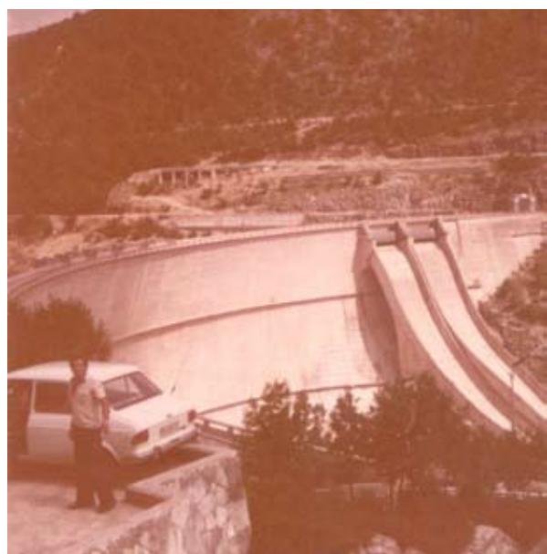
Jedna ze zwiedzanych żelbetowych zapór piętujących w Dalmacji, wrzesień 1981 Fot. archiwum autora
