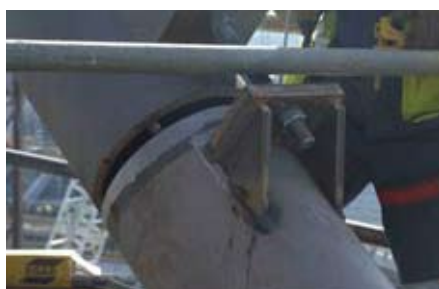
Rys. 10. Montaż części dachowej dźwigara i problemy ze spasowaniem styku
