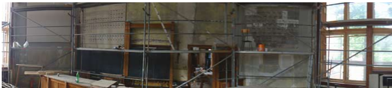
Zdj. 5. Ściana frontowa Audytorium Chemicznego w czasie prac rewitalizacyjnych lipiec 2010 r.
