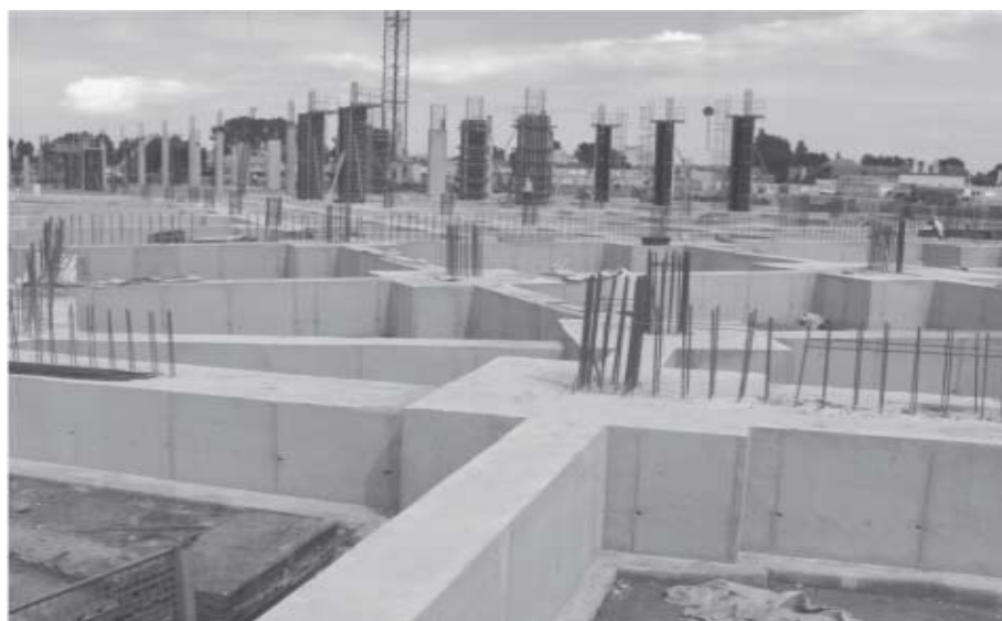
Stopy fundamentowe połączone rusztem belkowym
