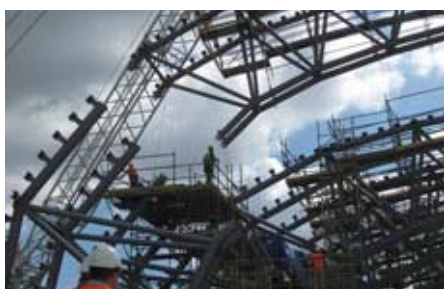
Rys. 10. Montaż części dachowej dźwigara i problemy ze spasowaniem styku
