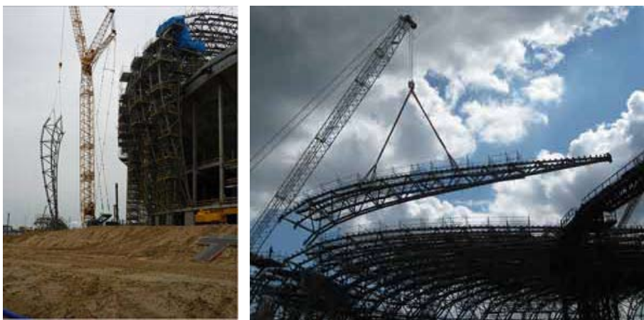
Rys. 6. Montaż części elewacyjnej i dachowej
