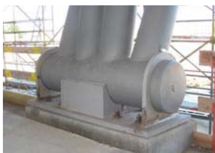
Rys. 11. Część podporowa dźwigara i miejsce pobrania próbek betonu do badań
