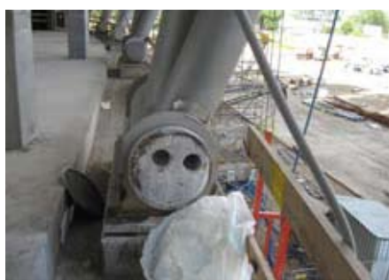
Rys. 11. Część podporowa dźwigara i miejsce pobrania próbek betonu do badań
