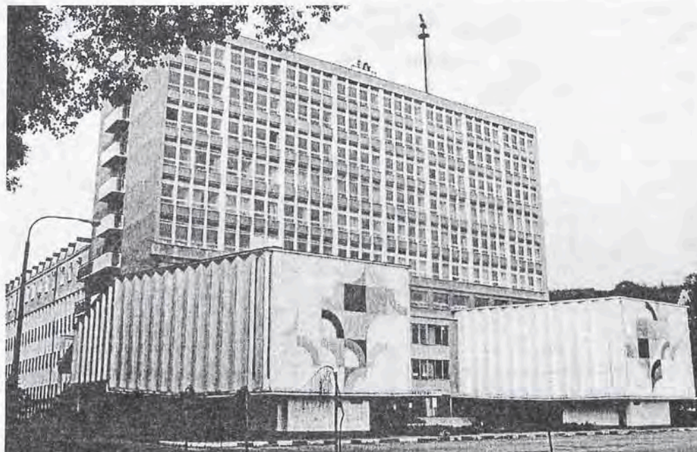
Budynek Wydziału Oceanotechniki i Okrętownictwa (Fot. B. Urbanowicz)
