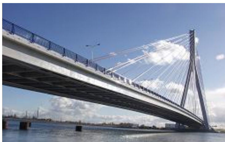
Rys. 3.17. Most przez Martwą Wisłę w Gdańsku: widok ogólny
