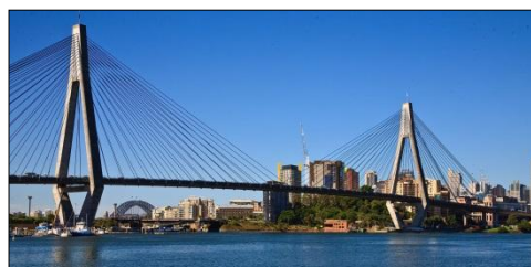
Rys. 3.51. Anzac Bridge ( en.wikipedia.org )
