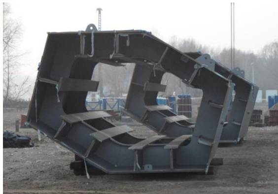
Rys. 6.19. Most łukowy przez Wisłę w Toruniu, sekcja montażowa na placu budowy i wg dokumentacji warsztatowej
