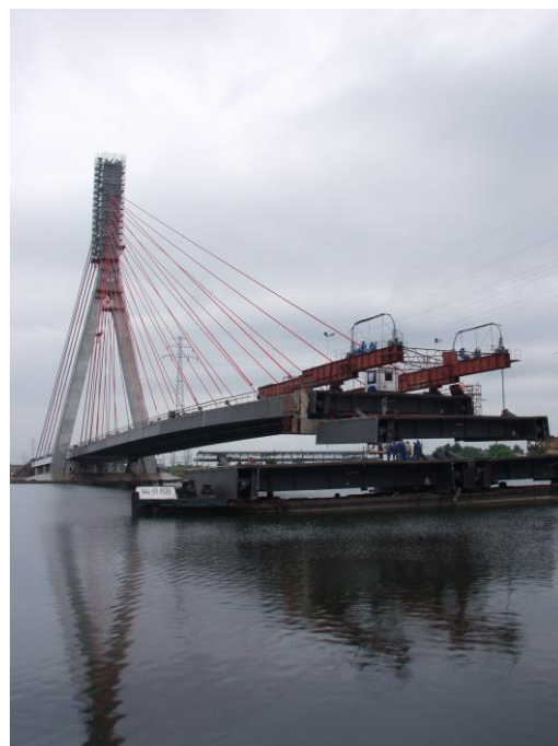
Rys. 4.6. Montaż wspornikowy
