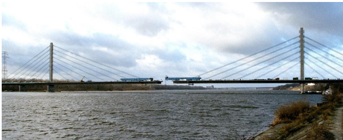
Fot. 6.3. Most wantowy przez Wisłę w Płocku, montaż wspornikowy mostu
