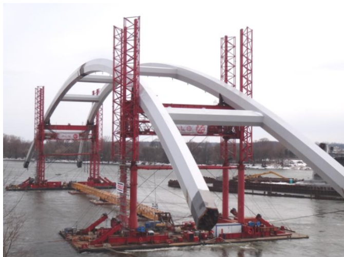
Rys. 6.16. Most łukowy przez Wisłę w Toruniu. Transport wodny łuków
