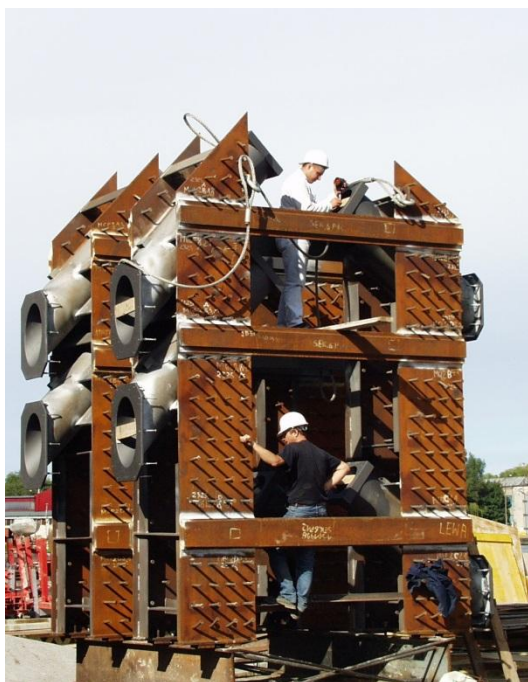
Rys. 4.5. Pylon – rama zakotwień want
