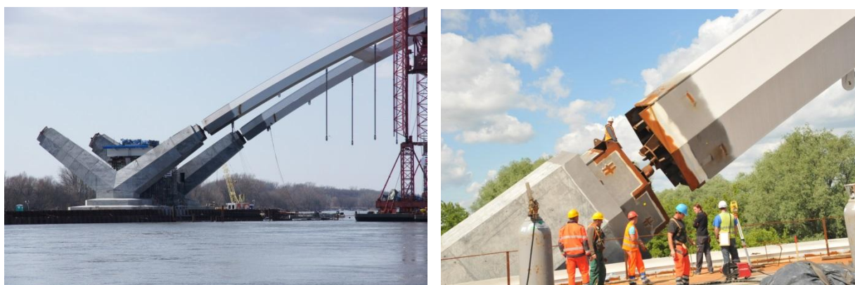
Rys. 6.17. Most łukowy przez Wisłę w Toruniu, osadzenie łuku na węzłowiach
