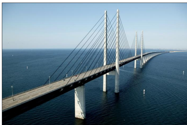
Rys. 3.5. ORESUND BRIDGE: widok ogólny mostu ( http://tenspeedhero.com )
