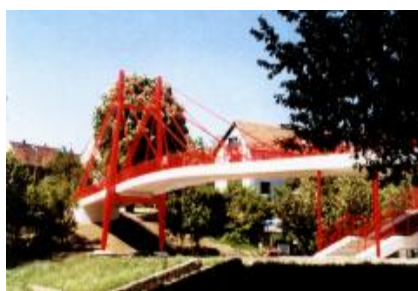
Rys. 3.63. Kładka ul. Wilcza w Szczecinie ( http://www.zoltowscy.org.pl )
