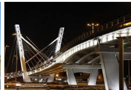
Rys. 3.62. Wiadukt nad ul. Żółkiewskiego w Toruniu ( www.torun.naszemiasto.pl )
