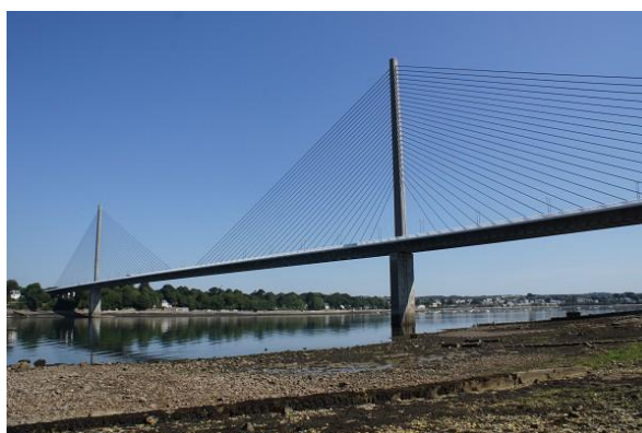
Rys. 3.3. ELORN (Iroise) BRIDGEI: widok ogólny mostu ( http://structurae.net )
