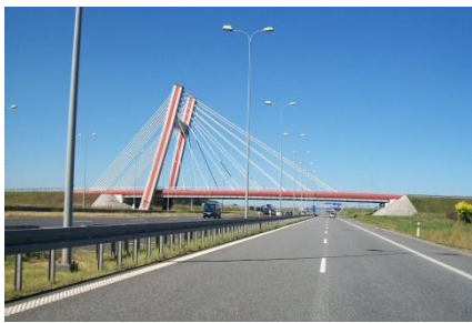
Rys. 3.61. Wiadukt na Węźle Sośnica A4 ( www.panoramio.com foto: J.Wierciński)
