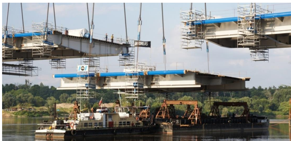
Rys. 6.18. Most łukowy przez Wisłę w Toruniu, montaż pomostu
