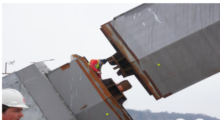
Rys.6.22. Oparcie łuku na węzłowaniu poprzez montażowe sworznie naprowadzające
