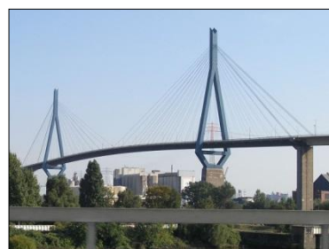
Rys. 3.44. Köhlbrand Bridge ( www.structurae.net )
