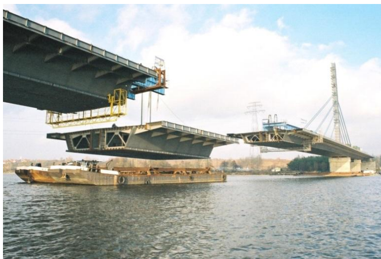
Fot. 6.6. Most wantowy przez Wisłę w Płocku, podnoszenie z pontonu typowego segmentu mostu (HILDEBRAND I INNI [2005])
