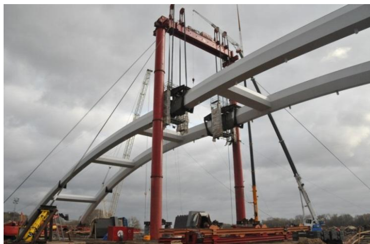
Fot. 6.15. Most łukowy przez Wisłę w Toruniu. Wieża montażowa - połączenie łuku w kluczu
