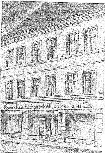
Abbildung 2: Die Straßenfront des Porzellangeschäfts nach dem Umbau. Die Mauerpfeiler sind mit Verblendplatten verkleidet; die beiden Leuchten an der Fassade sind durch Kunstschmiedearbeiten mit Porzellanglocken ausgetauscht worden.
