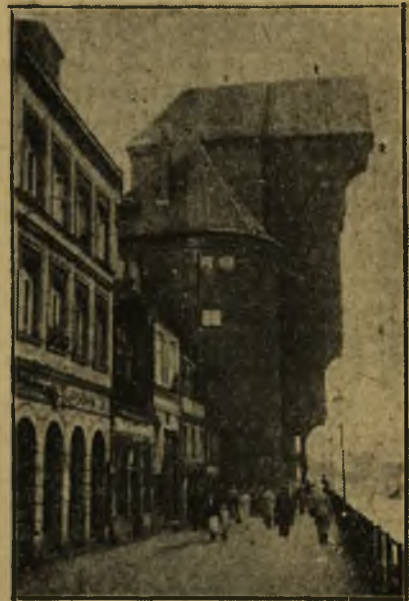
Stary, polskie pamiętający czasy, dźwig (kran) portowy w Gdańsku (Fot. E. Kuleza)
