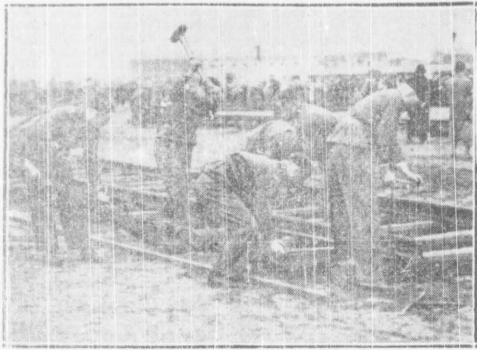
Trójki kolejarzy-wojskowi. Budowa toru.
