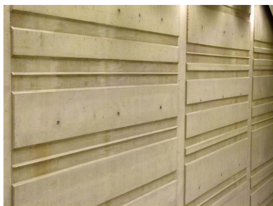
Rys. 11. CNT, detal –wzór odcisku szalowania w głównym audytorium Fig. 11. CNT, detail –concrete formwork imprint in the main auditorium Źródło: Fot. T. Wagner
