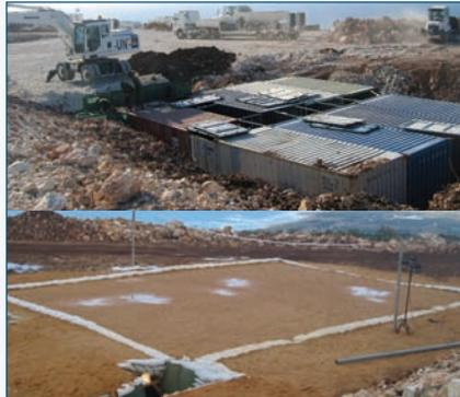
Bunker com contentores de carga geral (construção e final)
