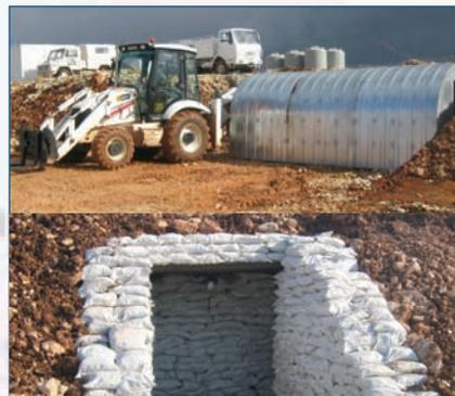
Bunker com estrutura metálica (construção e final)
