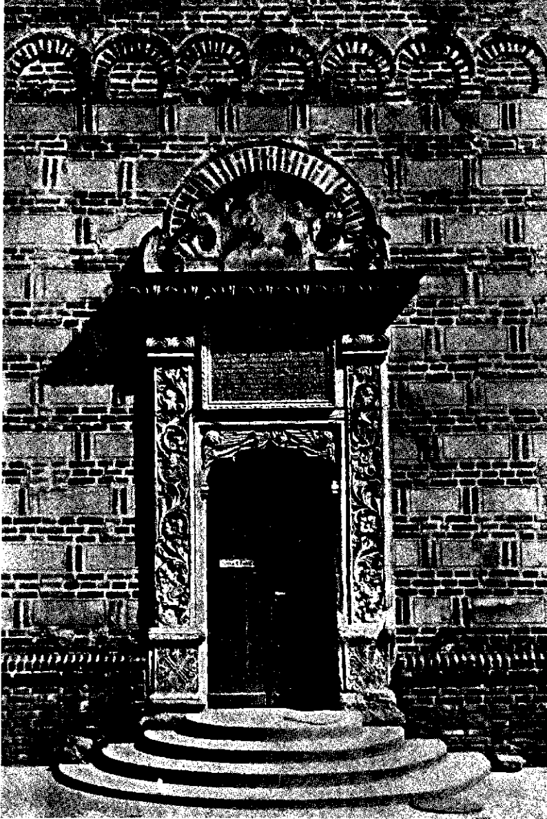
Fig. 81. — Biserica Curtea Veche. Portalul și detaliu de fațadă (clișeu ICSOR).
