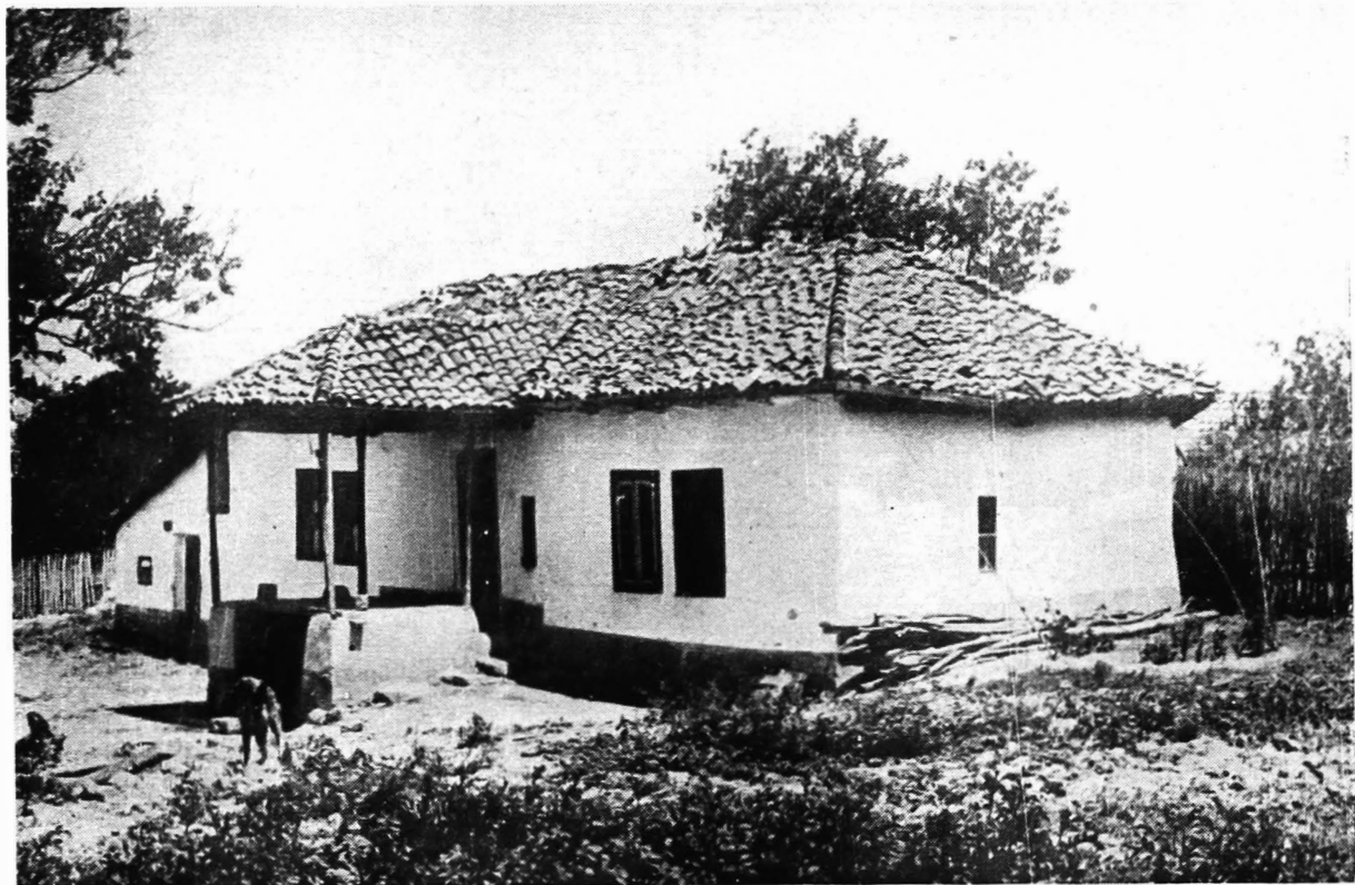
112. Babadag. Casă cu balcon jos, peste girliciul scund al pivniței, fără balustradă, acoperit în trei ape
