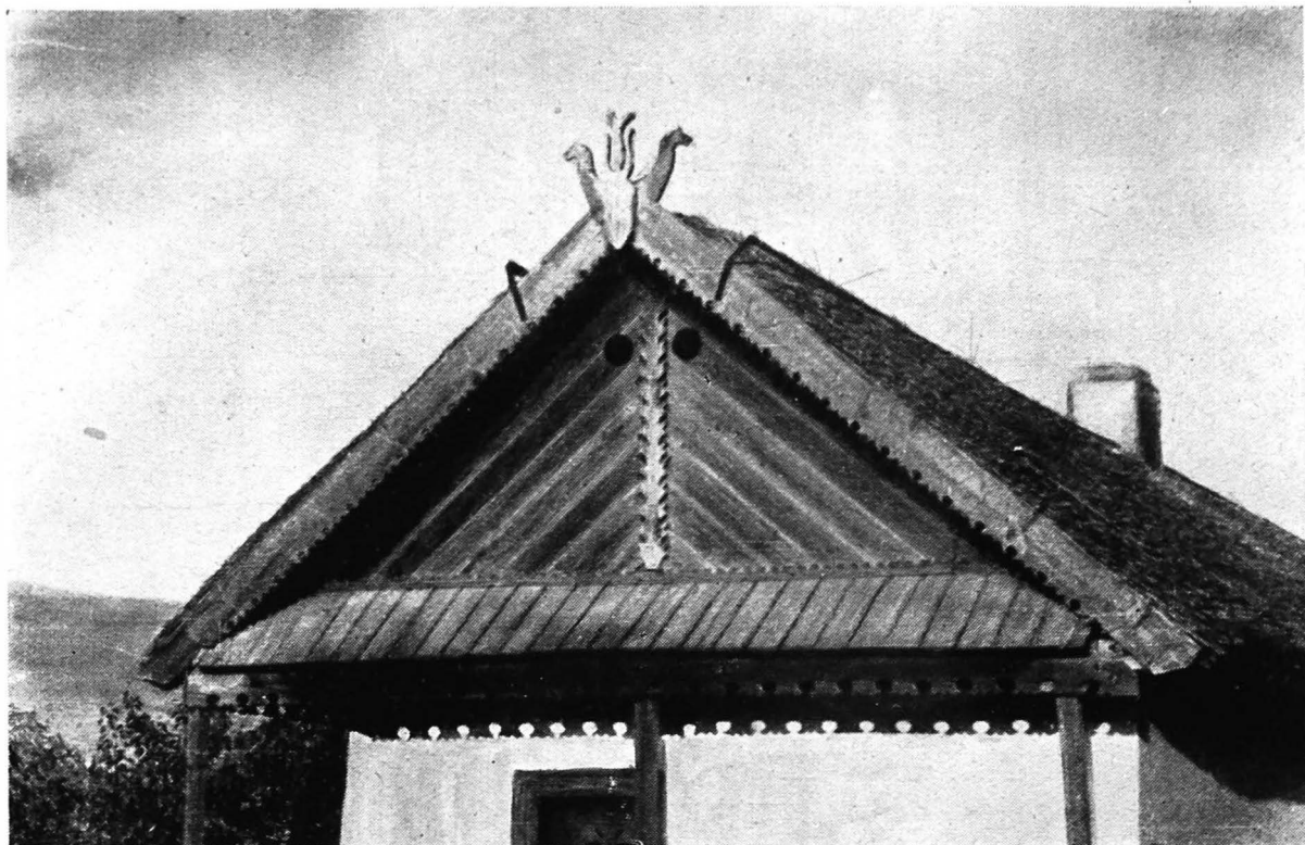
154. Malmudia. Timpan cu două ochiuri rotunde. Ornamentație simplă. La coamă, paziile terminate în cap de cal
