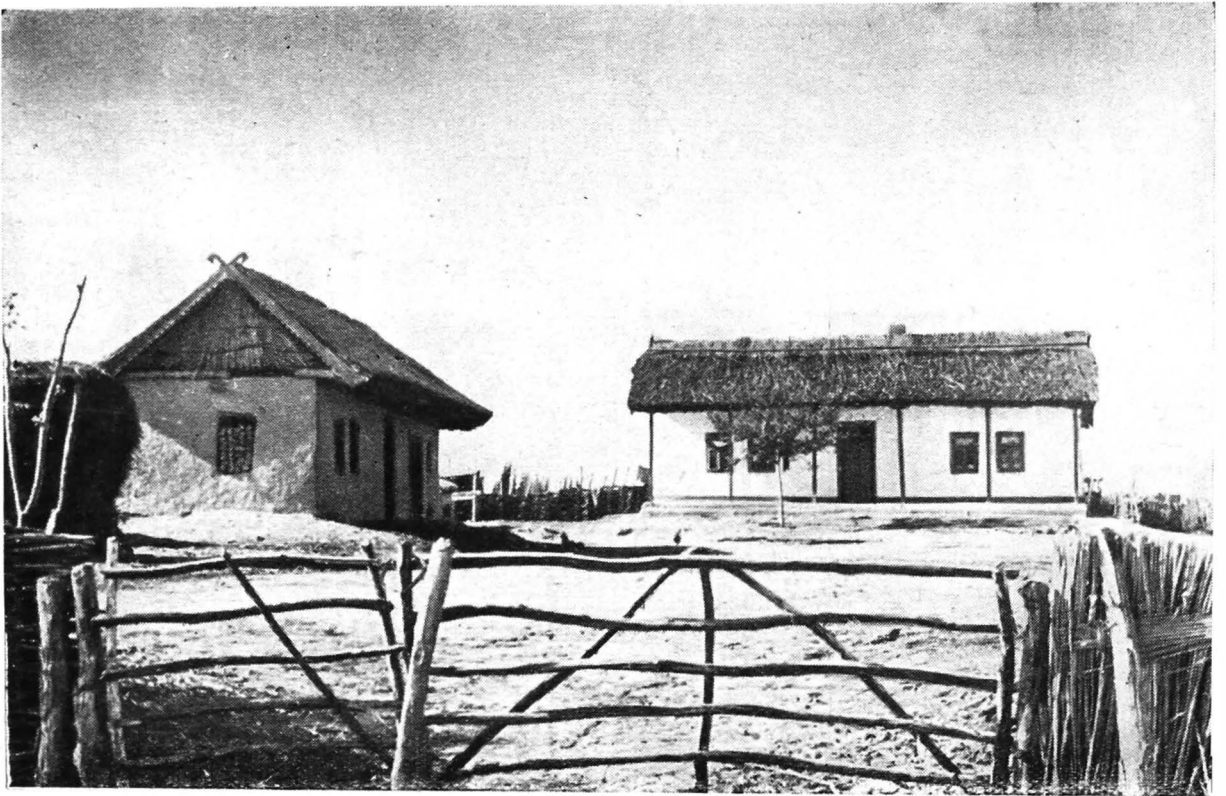
122. Ilganii de Jos. Tip de gospodărie în Deltă. Construcții acoperite în două ape cu trestie, cu pazii terminate în cap de cal, retrase de la stradă mai pe înălțime din cauza viiturilor apelor Dunării
