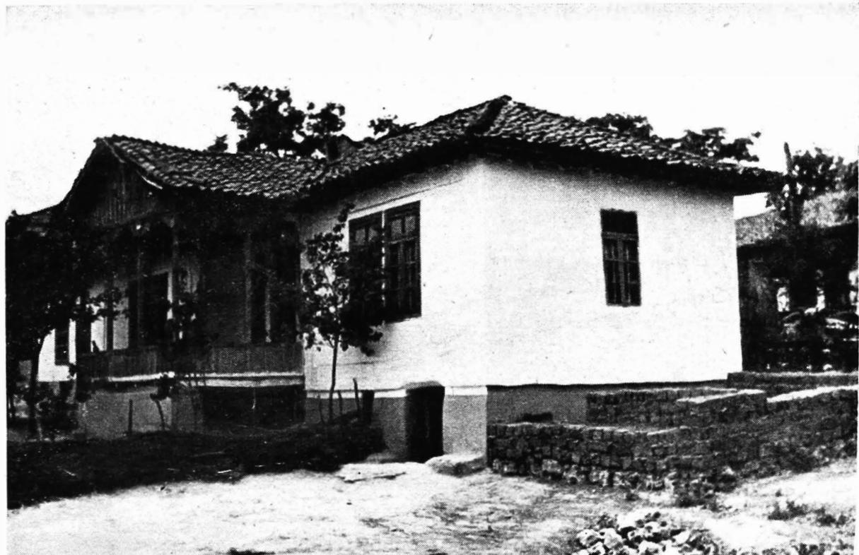
70. Oltina. Casă pe pivniță, mai puțin înălțată, cu balcon și tinda retrasă în dreptul său, dar fără prispă. Balconul acoperit în două ape, cu timpanul de scinduri
