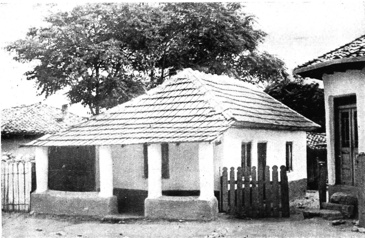
76. Băneasa. Casă din piatră, cu prispă pe stâlpi de zidărie, pe latura îngustă, în stradă, în afara împrejurii. Învelitoare din țiglă cu prelungire de pantă peste prispă
