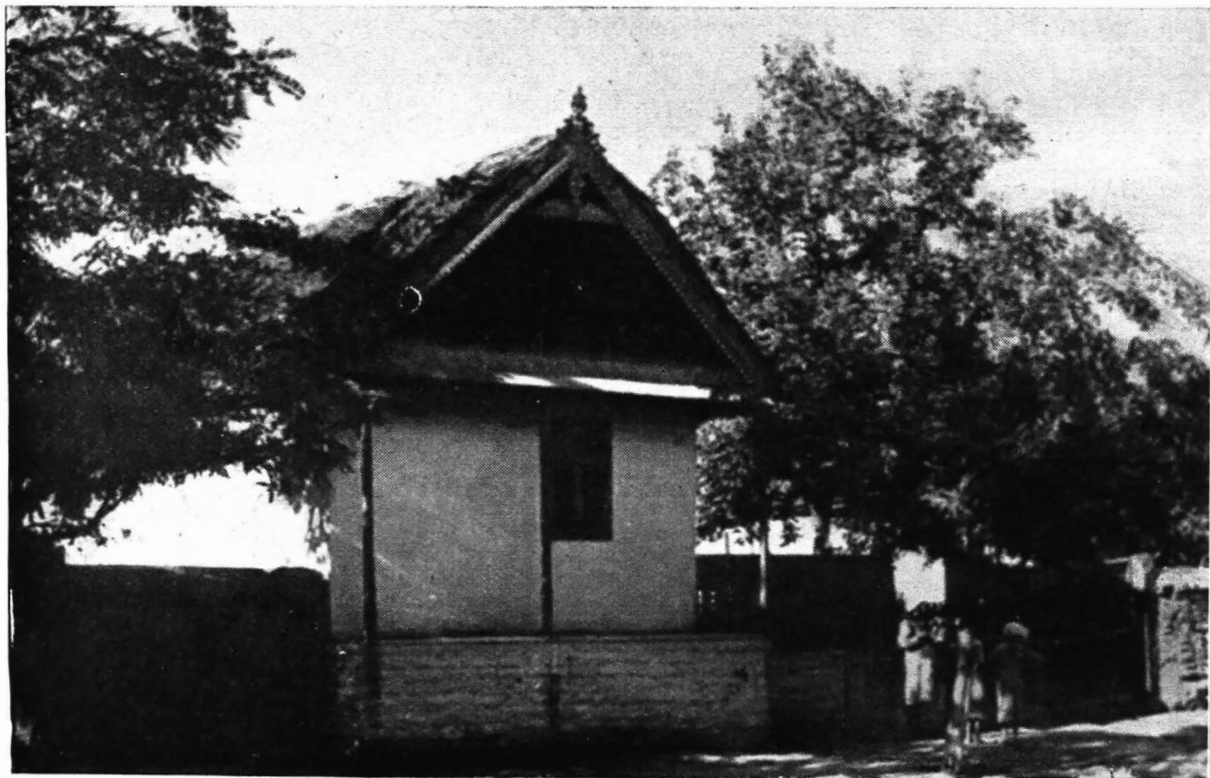
136. Slava Cercheză. Casă cu prispa întoarsă la stradă, pe trei stâlpi de lemn
