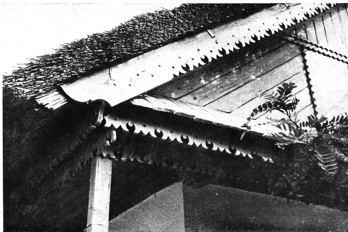
173. Mahmudia. Colț de fronton cu detaliu de ornamentație traforată a paziilor
