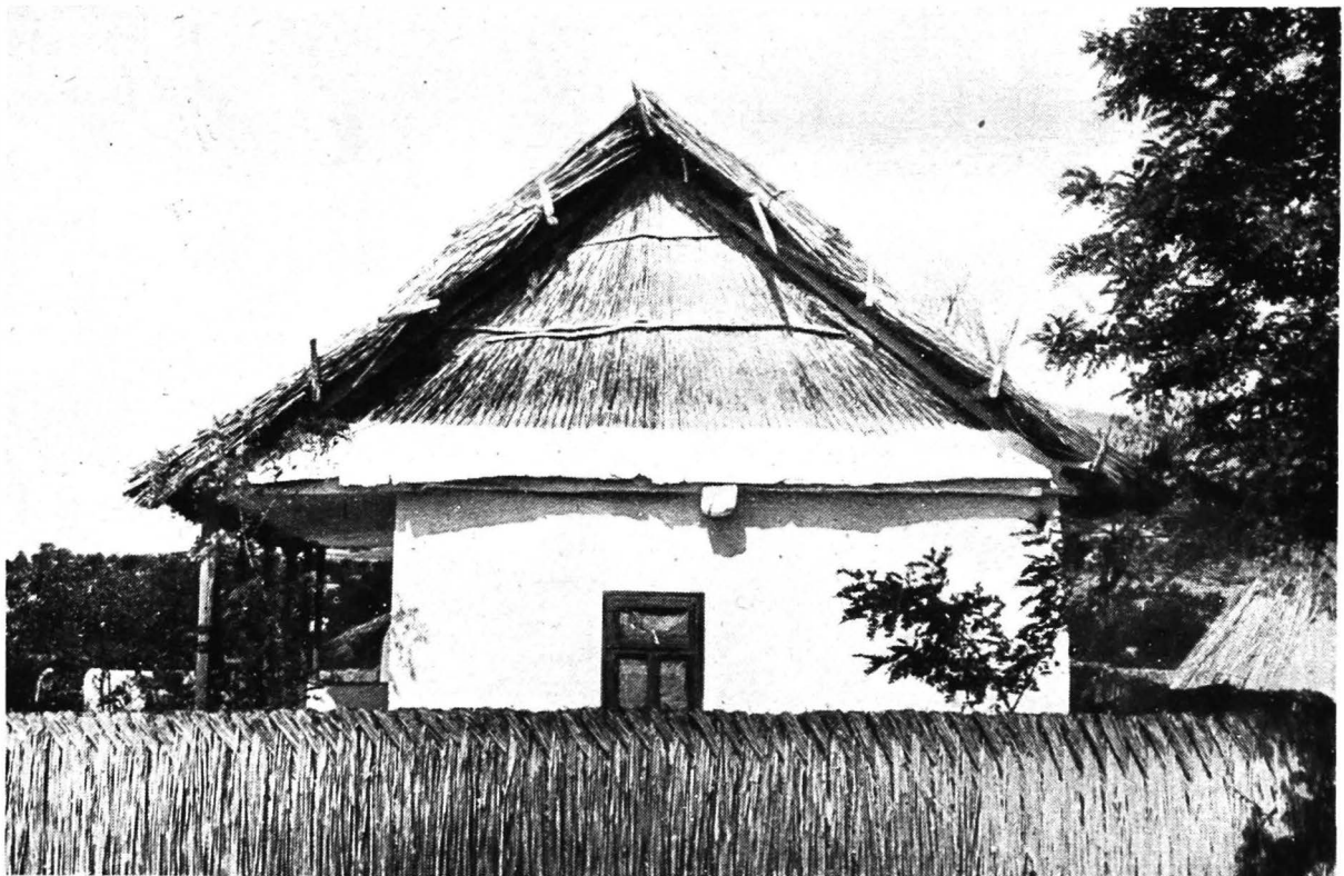
125. Mahmudia. Casă cu timpanul din trestie, fără pazii, de asemenea retrasă de la stradă, dar cu prispa pe latura lungă
