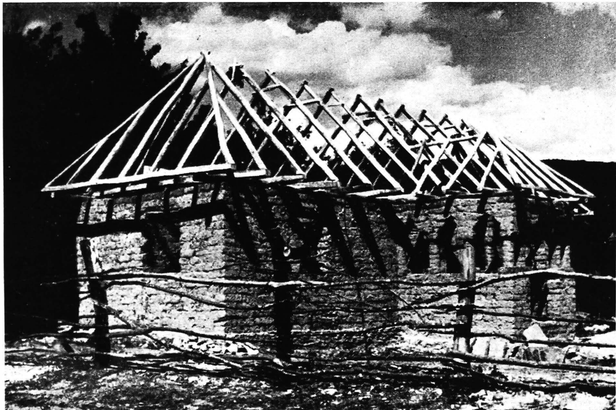
30. Ciucurova. Casă în construcție din chirpici, din care sînt făcuți și stîlpii și arcele balconului
