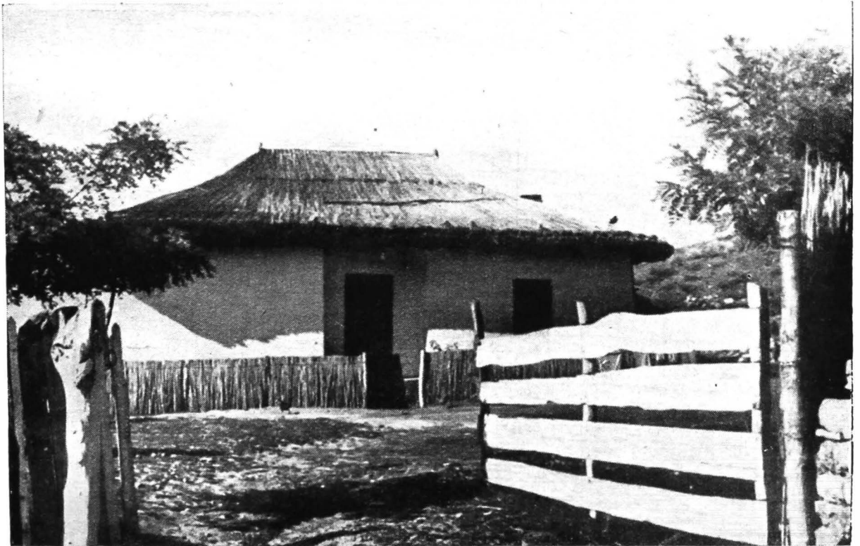
123. Ilganii de Jos. Casă de pescar, cu o prispă prin retragerea tindei, acoperită în patru ape, cu trestie așezată pescărește
