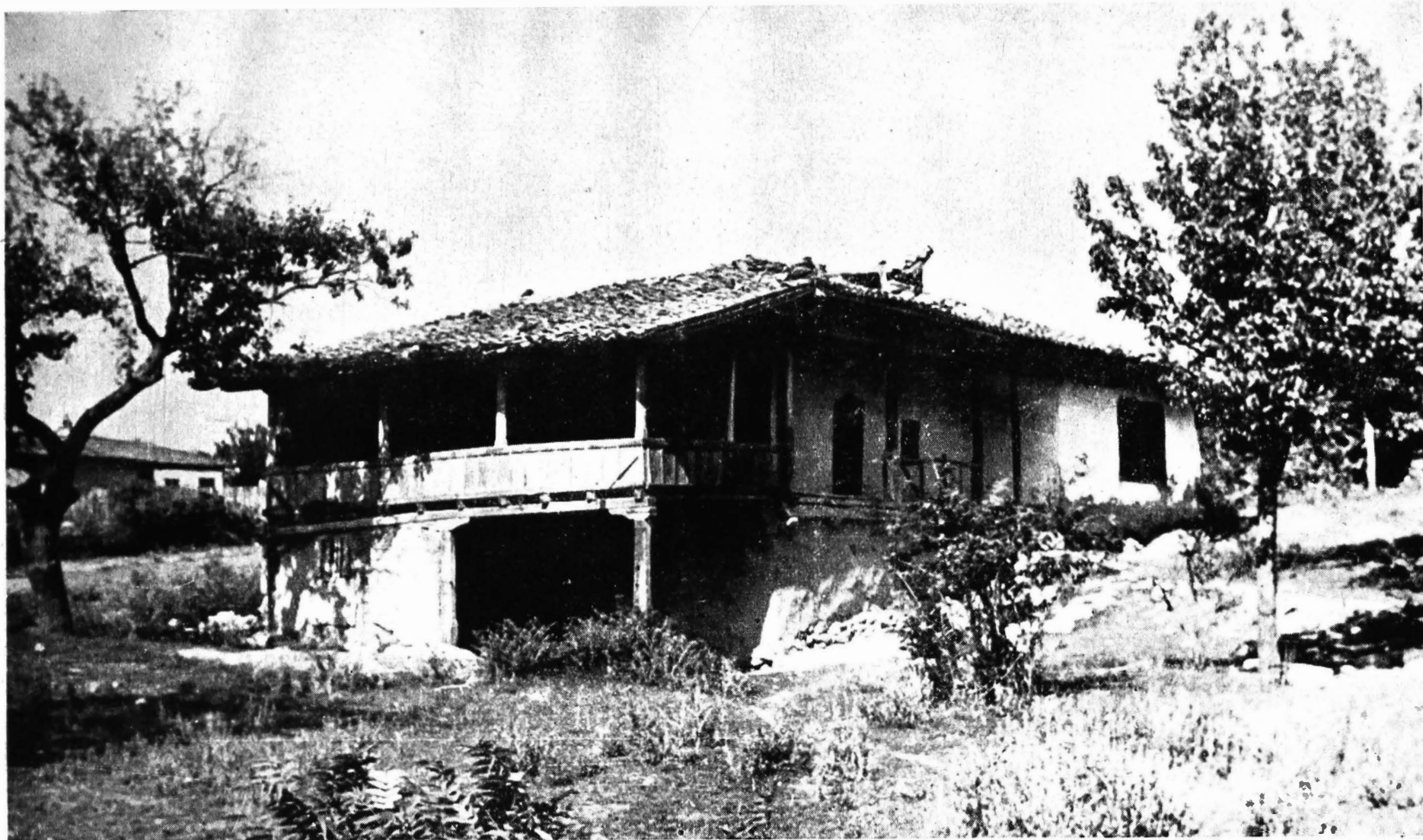
63. Cuiungiuc. Casă veche părăsită, formată din tindă și două camere, cu prispă parțială continuată cu un balcon larg pe latul casei, deasupra grajdului
