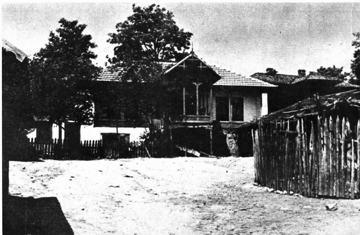
69. Negureni. Casa lui Petre Mocanu, înălțată pe pivniță și o cameră. Intrarea prin grădinișă în balconul înalt cu patru stâlpi, acoperit în două ape. Aceeași balustradă joasă și ferestre cuplate la camere
