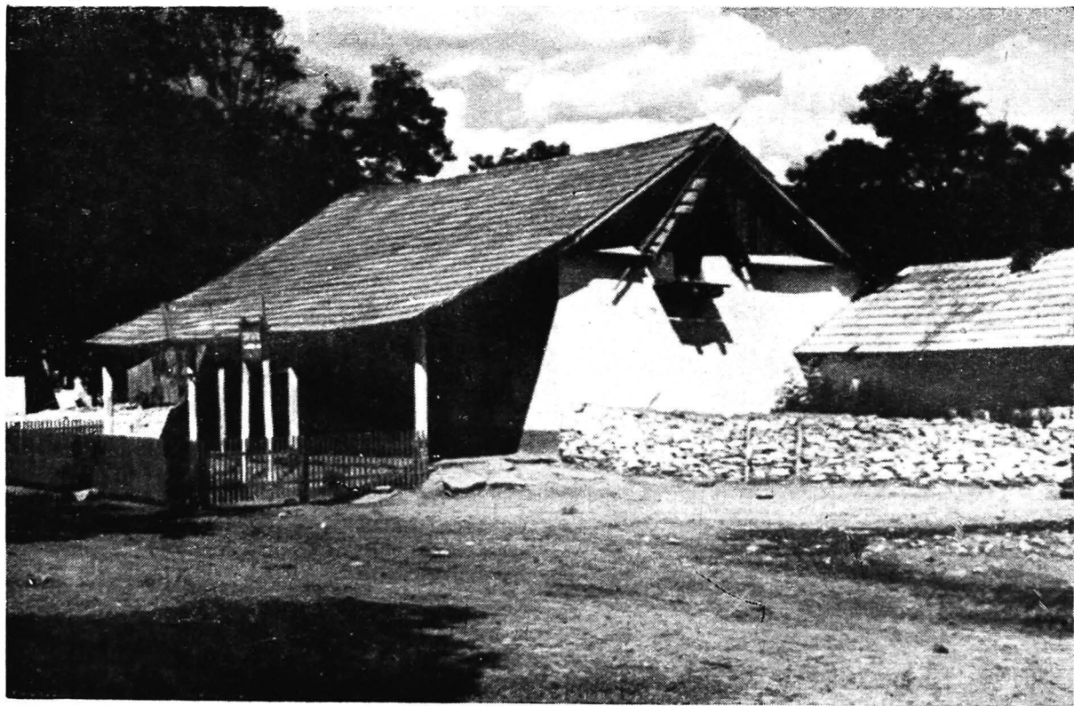
140. Ciucurova. Circiumă în piață, cu prispă largă pe stâlpi de lemn fără balustradă, acoperită în prelungire de pantă
