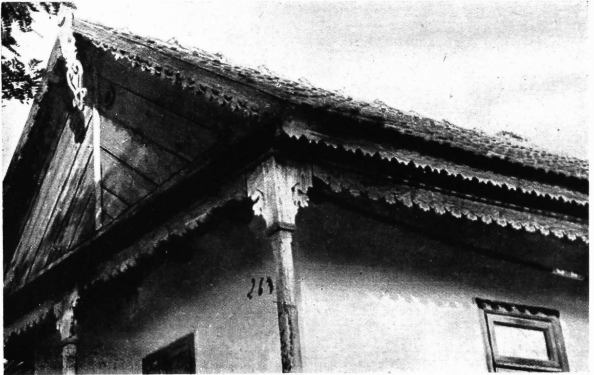
169. Ghindărești. Colț de casă cu fronton, detalii de săgeată, pazii cu motive diferite și cap de stîlp îmbrăcat în scinduri traforate
