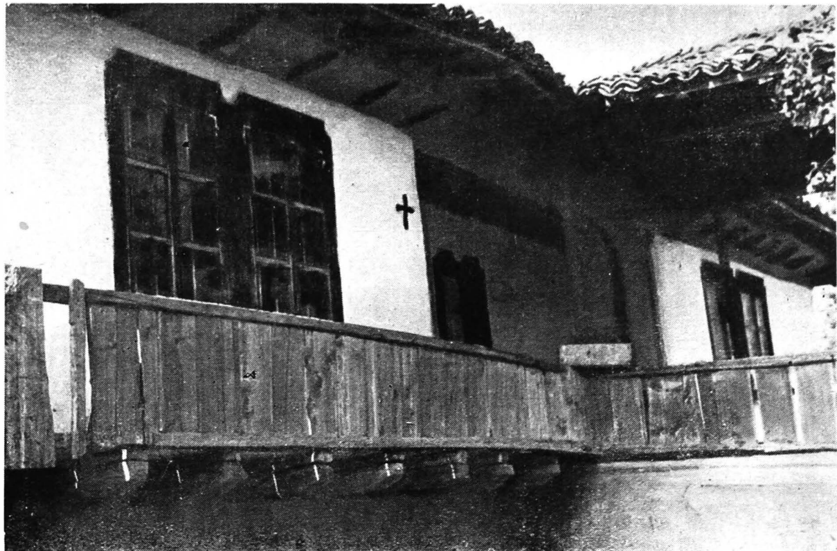
61. Cuiungiuc. Detaliu de prispă, în consolă pe grinzile planșeului. În dreptul balconului prispă este lărgită prin retragerea tindei
