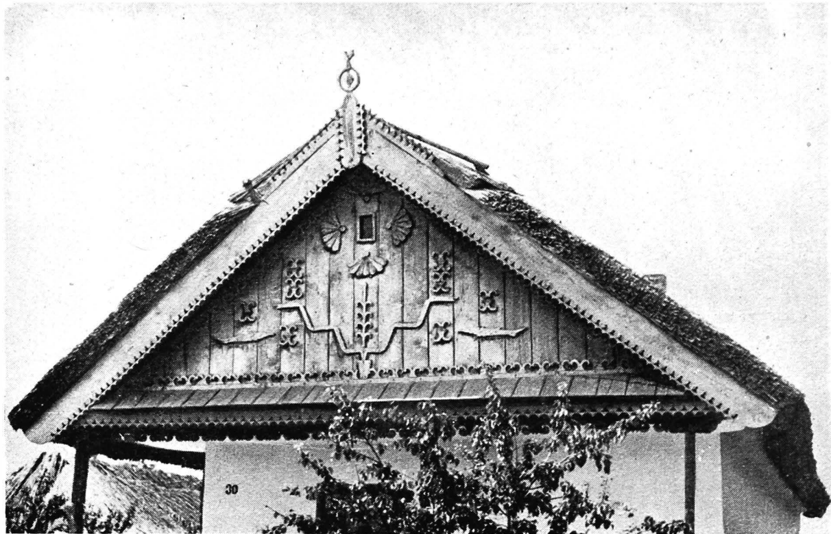
165. Mahmudia. Timpan din scinduri verticale cu decorație aplicată: „pomul vieții” cu lujerul roditor și două crengi laterale; deasupra streașinei o friză de cornițe, care, cuplate câte două, apar și în cîmp împreună cu doi pești. În jurul ferestruicii patru evantaie egale
