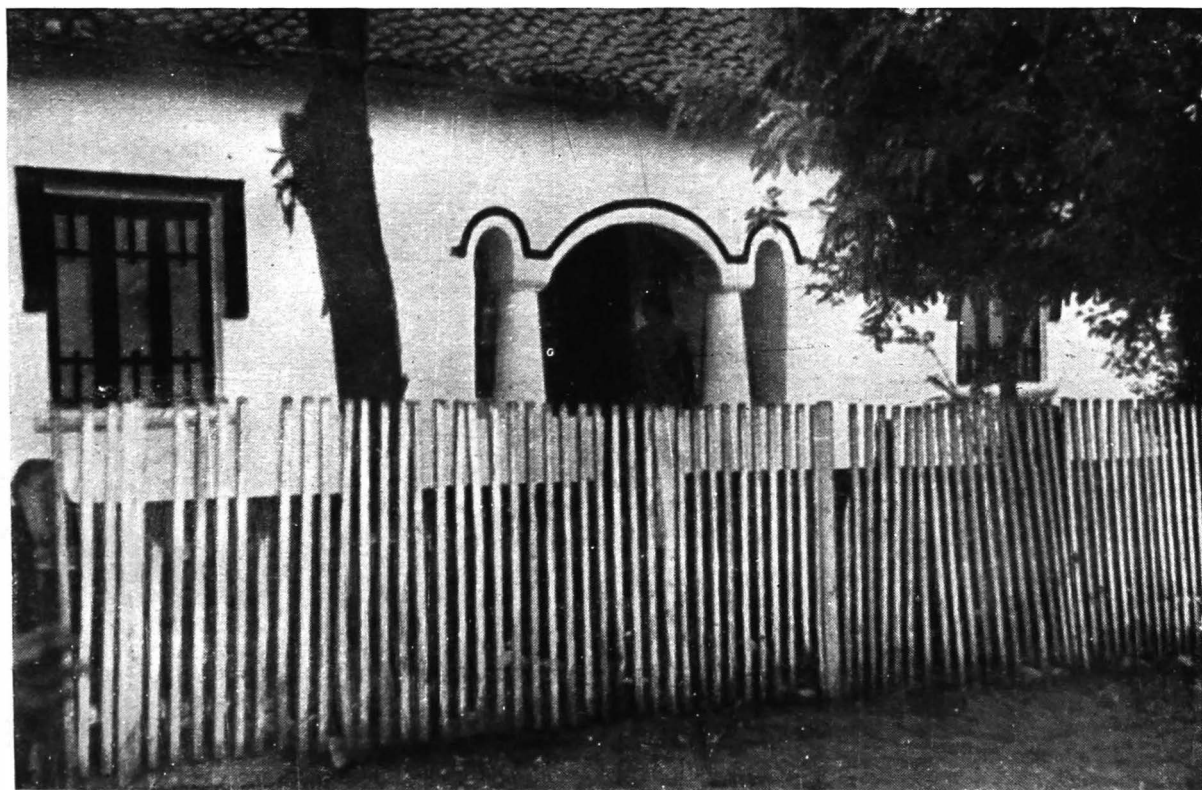
91. Bărăganul. Prispă formată prin retragerea tindei, la mijloc, între cele două camere, cu trei arcade și mai diferențiate, conturate ca și ferestrele cu un briu colorat
