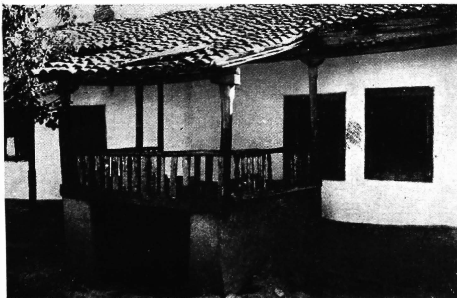
113. Babadag. Detaliu de balcon scund acoperit în prelungire de pantă, cu balustradă, ridicat peste girliciul pivniței
