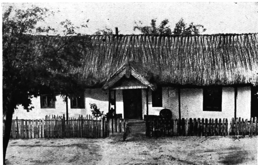
142. Murighiol. Casă mai dezvoltată, cu balconul foarte mic, acoperit în două ape, cu pazii traforate
