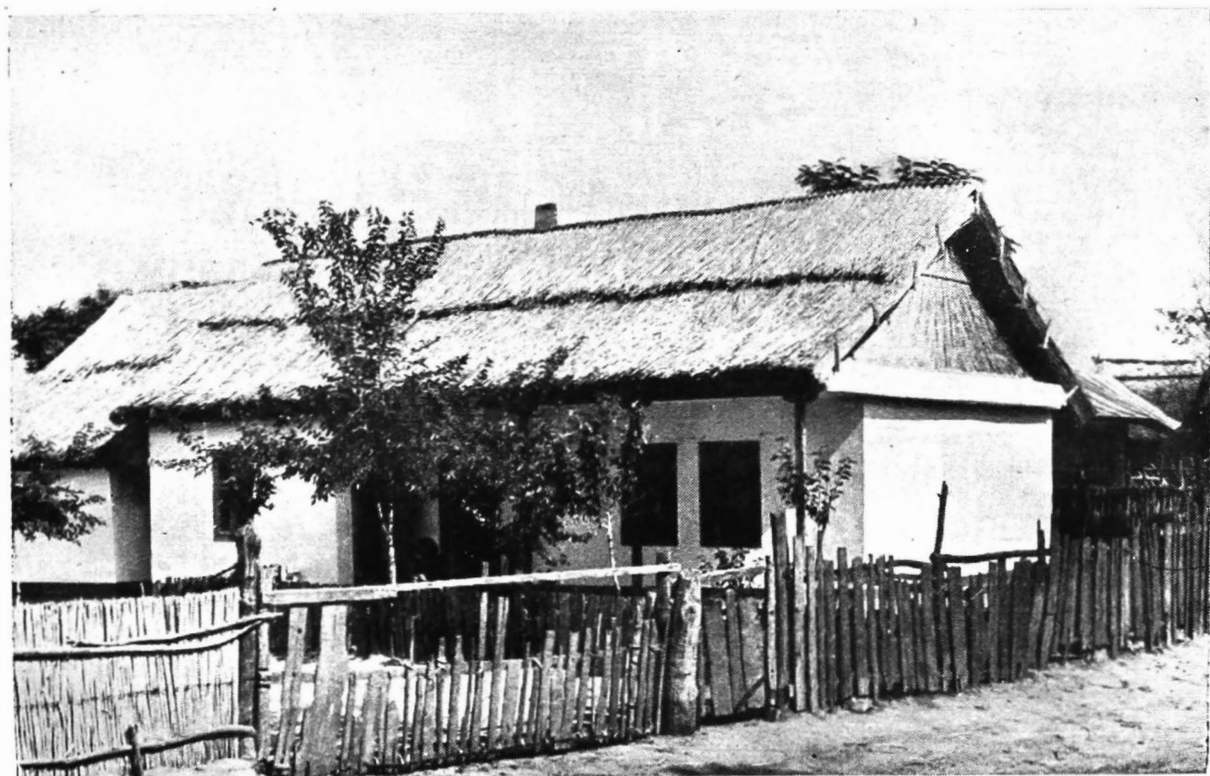
131. Murighiol. Casă cu prispă parțială acoperită cu trestie în rinduri și timpanul tot din trestie
