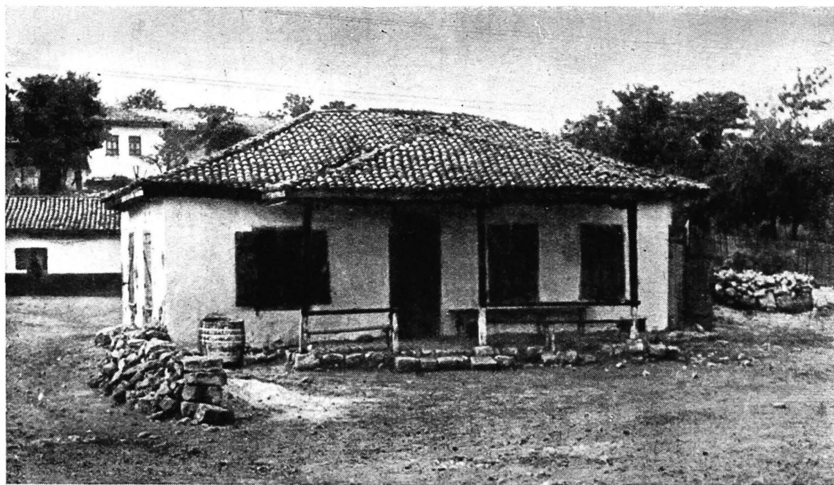
79. Cocargea. Han la drumul mare cu prispă parțială în mijloc, pe trei stâlpi de lemn, acoperită în trei ape. O intrare din prispă și a doua pe colțul țesit, închise cu obloane ca și ferestrele
