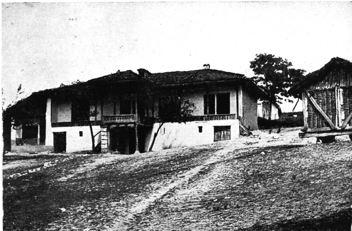
66. Carvanul Mare. Casa Mariei C. Anton. Tip evoluat cu tindă și trei camere peste pivnițe și grajd, cu bucătărie de vară în chilerul din stînga. Un balcon înalt în fața prispei cu intrare prin capăt și închisă în celălalt
