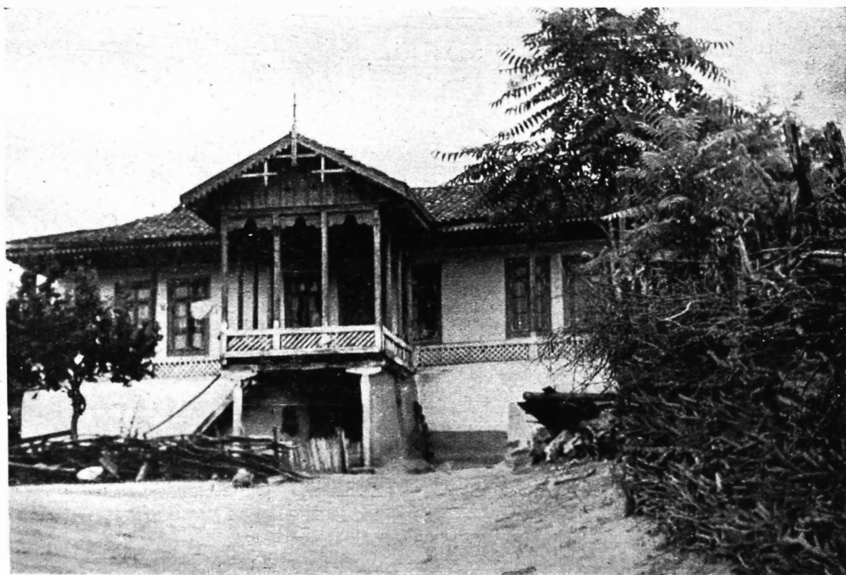
71. Oltina. Casă înălțată, cu prispă și balcon pe patru stilpi legați la partea superioară prin scinduri tăiate în arce ondulate. Ornamentație foarte simplă de trafor și la pazii
