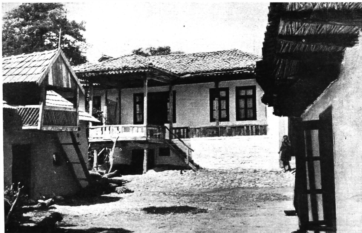
67. Ion Corvin. Casa lui Petru I. Culea, mai puțin înălțată, cu tindă și două camere. Intrarea prin balcon, peste girliciuul pivniței. Balustrada joasă dă înălțime stîlpilor
