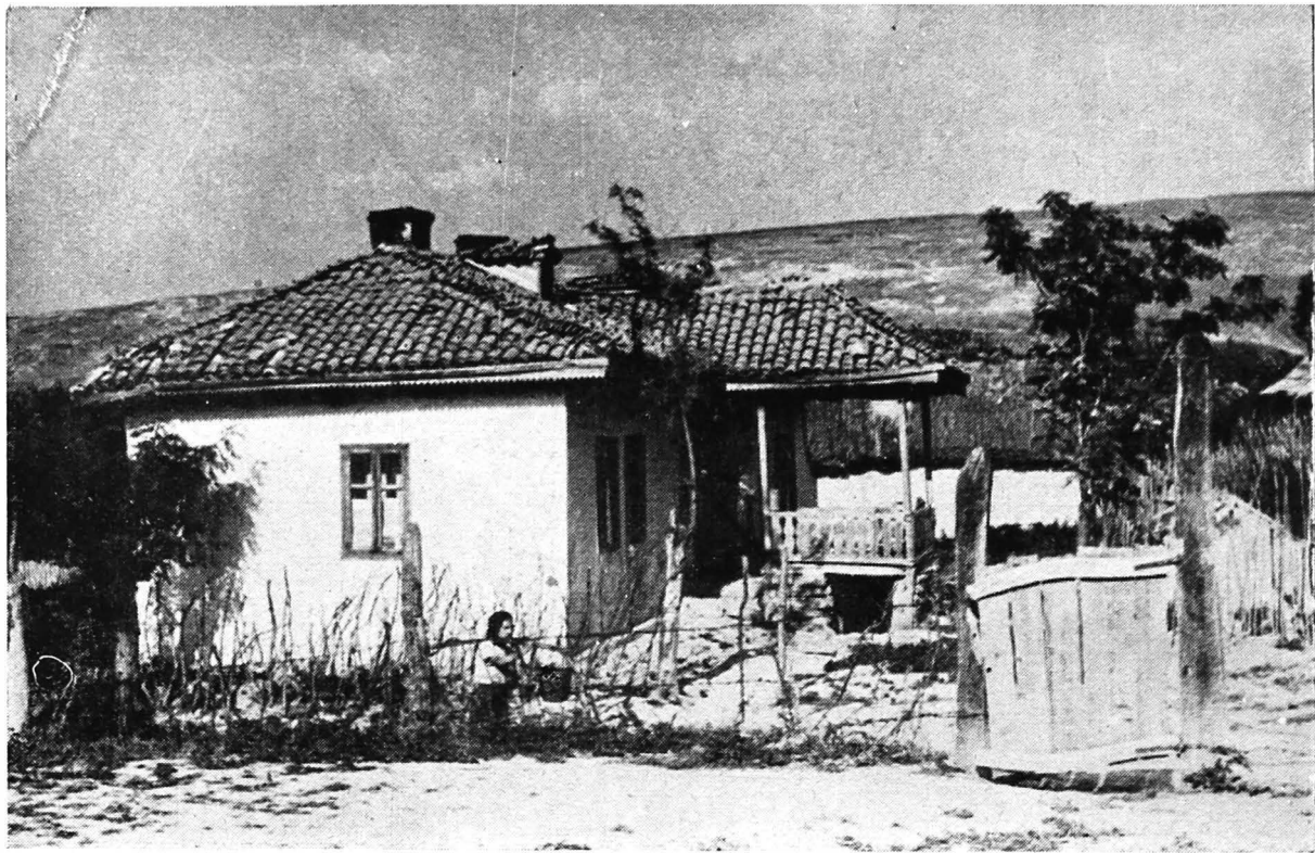
114. Babadag. Casă cu balcon jos, peste girliciul pivniței, pe stâlpi de lemn cu balustradă, acoperit în trei ape
