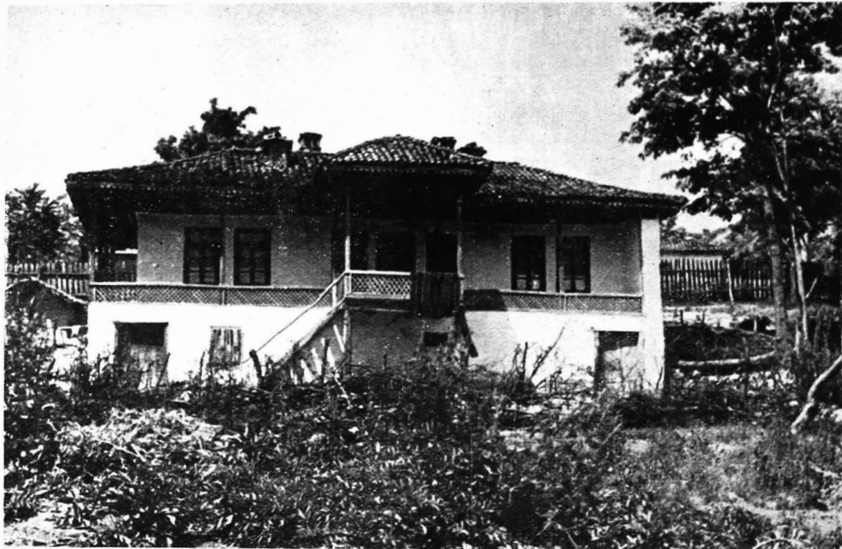
68. Negureni. Casa lui Oane Florescu, cu tindă și două camere ridicate la etaj. O scară repede urcă în balconul cu doi stâlpi, acoperit în trei ape, din fața prispei ce se întoarce și pe latura îngustă
