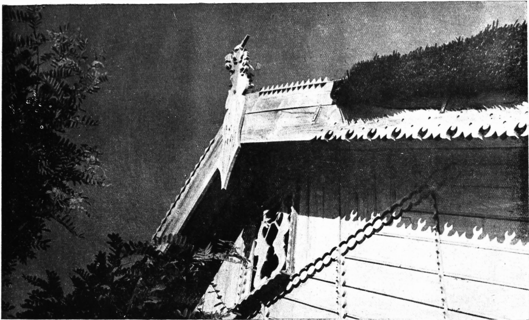
182. Mahmudia. Detaliu de fronton cu cai de mare în fereastra timpanului. Săgeata din două scinduri traforate și îmbinate în cruce, terminată în vîrf cu o pasăre
