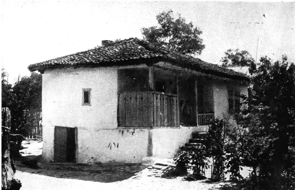
107. Babadag. Casă ridicată pe pivniță, cu prispă parțială închisă pe colțul dinspre stradă cu un parapet înalt de scinduri
