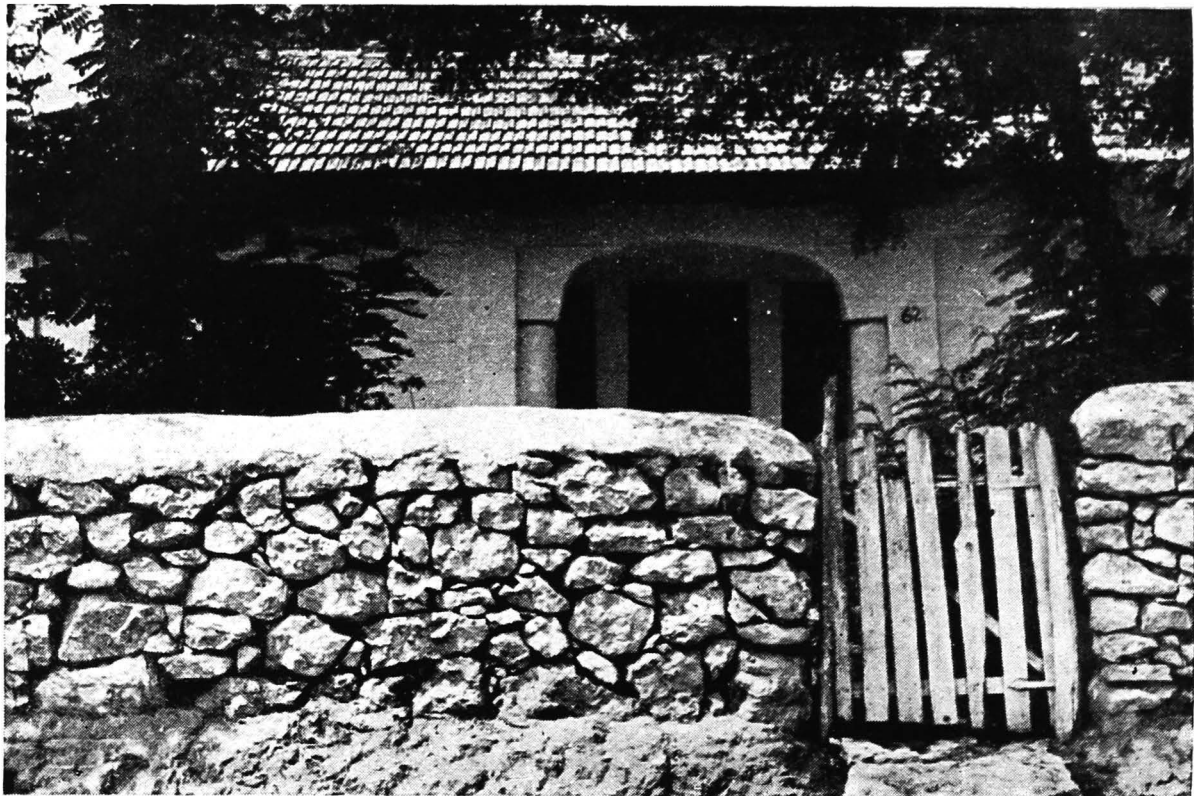
31. Crucea. Împrejmuire de piatră zidită cu lut și acoperită cu lipitură de lut amestecat cu var
