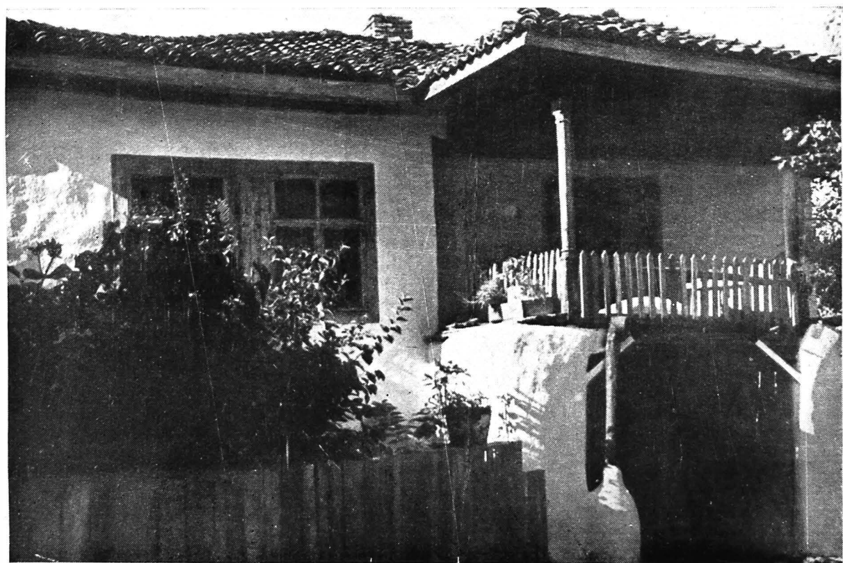
115. Babadag. Detaliu de balcon. În fața prispei retrase balconul cu balustradă ridicat peste girliciul înalt în care se află cuptorul de piine
