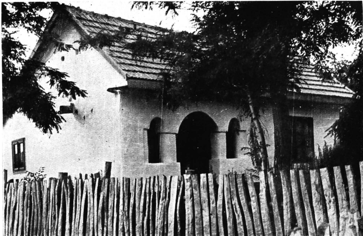
90. Tichilești. Casă cu tindă retrasă, o cameră și chiler în spate. Prispa, pe colț, cu trei arce inegale pe stâlpi zidiți deasupra parapetului
