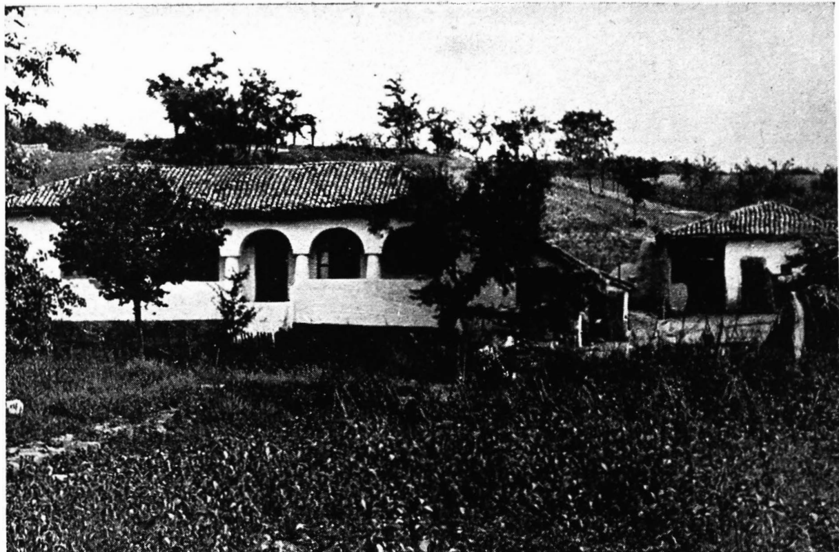
84. Cocargea. Casa lui Dumitru Lazăr, cu prispă parțială cu patru arce pe stâlpi zidiți pe parapetul plin, la fața soclului. Spre dreapta acoperișul de olane prelungit în chiler
