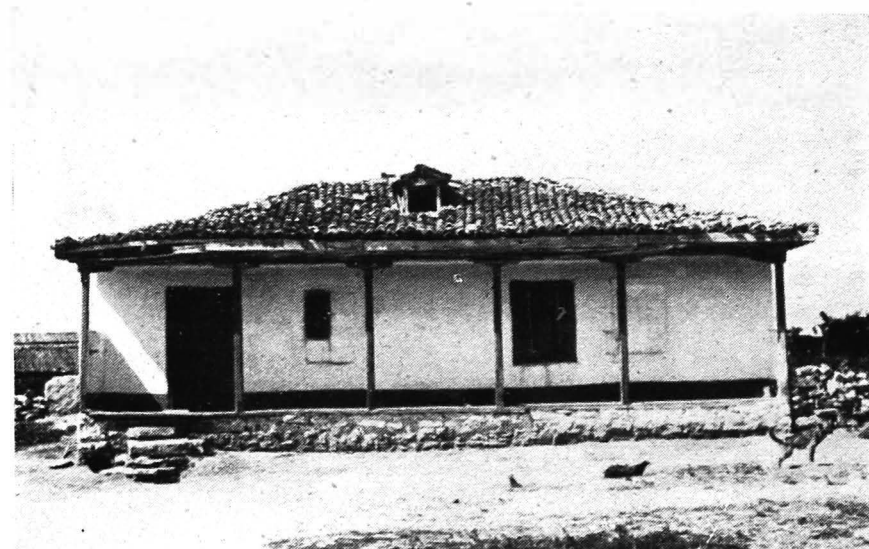
103. Babadag. Casă joasă, cu prispa pe șase stâlpi de lemn fără balustradă
