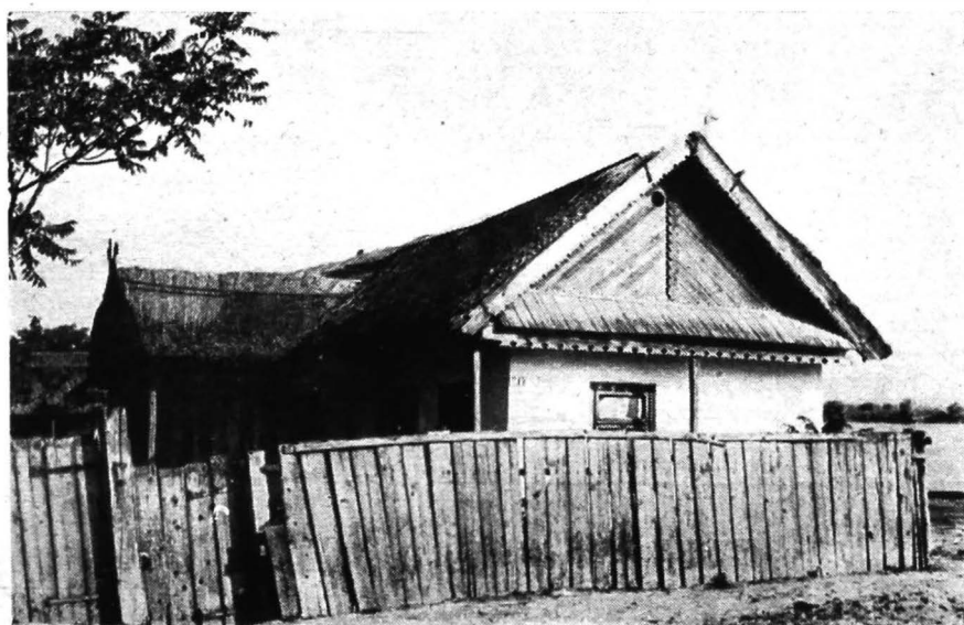
143. Mahmudia. Casă cu prispa pe două laturi și balcon mai mare. Atît frontonul dinspre stradă cît și al balconului cu ornamente mai bogate
