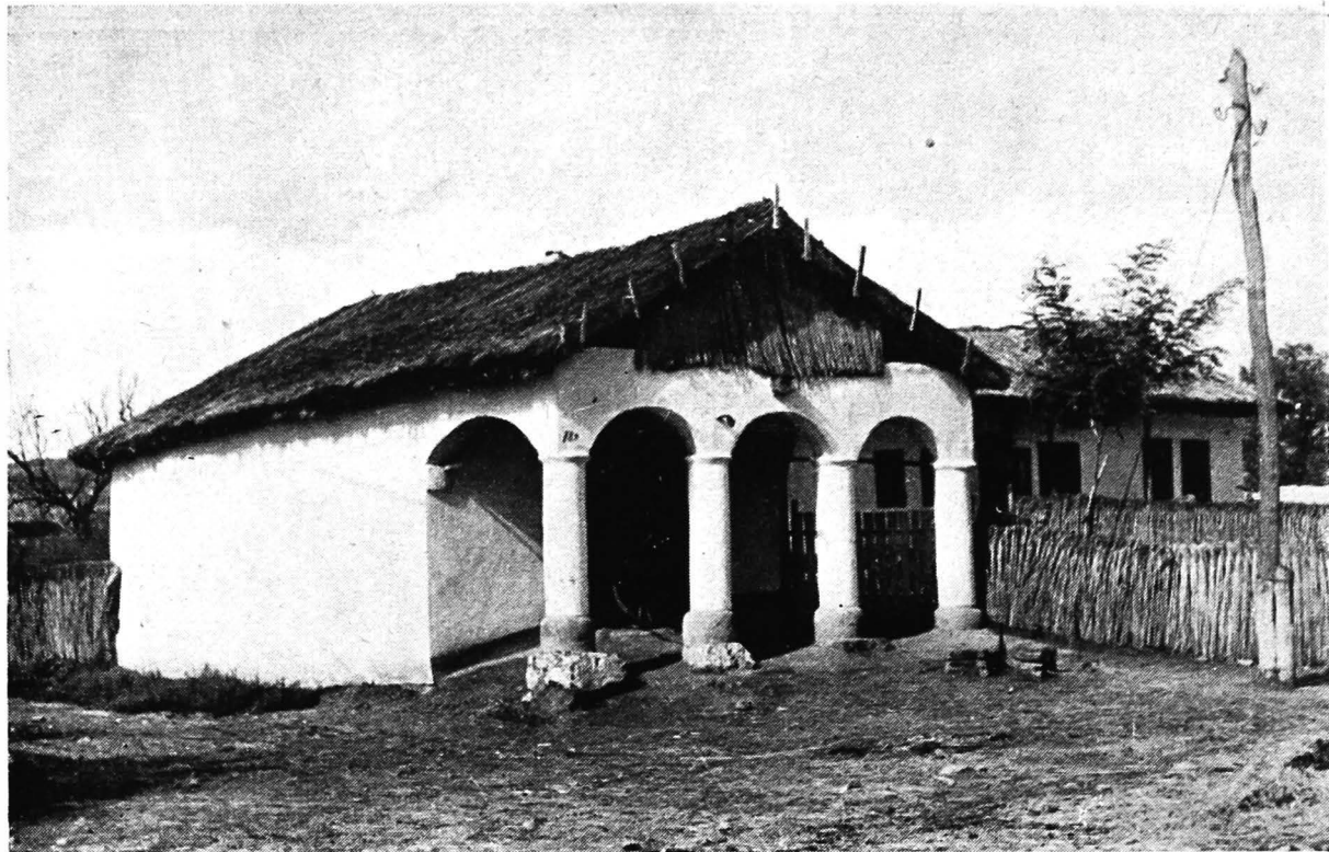
139. Ada Marinescu. Atelier de meșteșugar la colț de stradă. Prispă pe latura îngustă cu stâlpi de zidărie cu arcade. Învelitoare, timpan și gard de trestie
