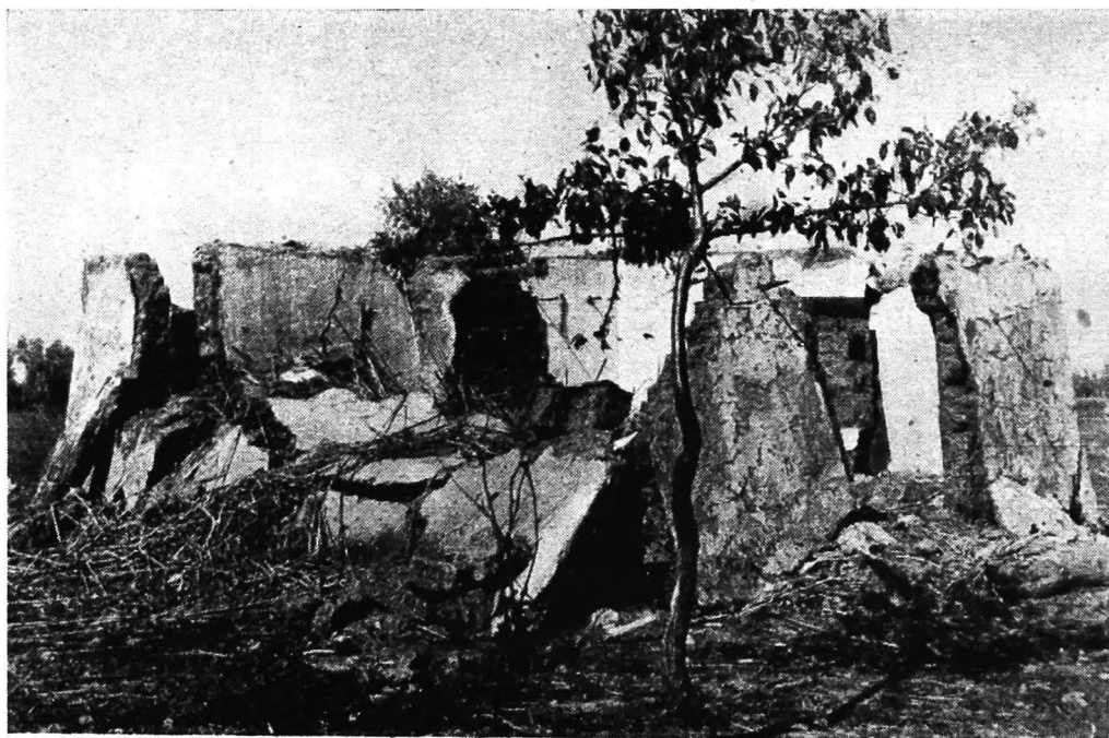
29. Ruinele unei case de ciamur, dărîmată de viitura apelor în Delta
