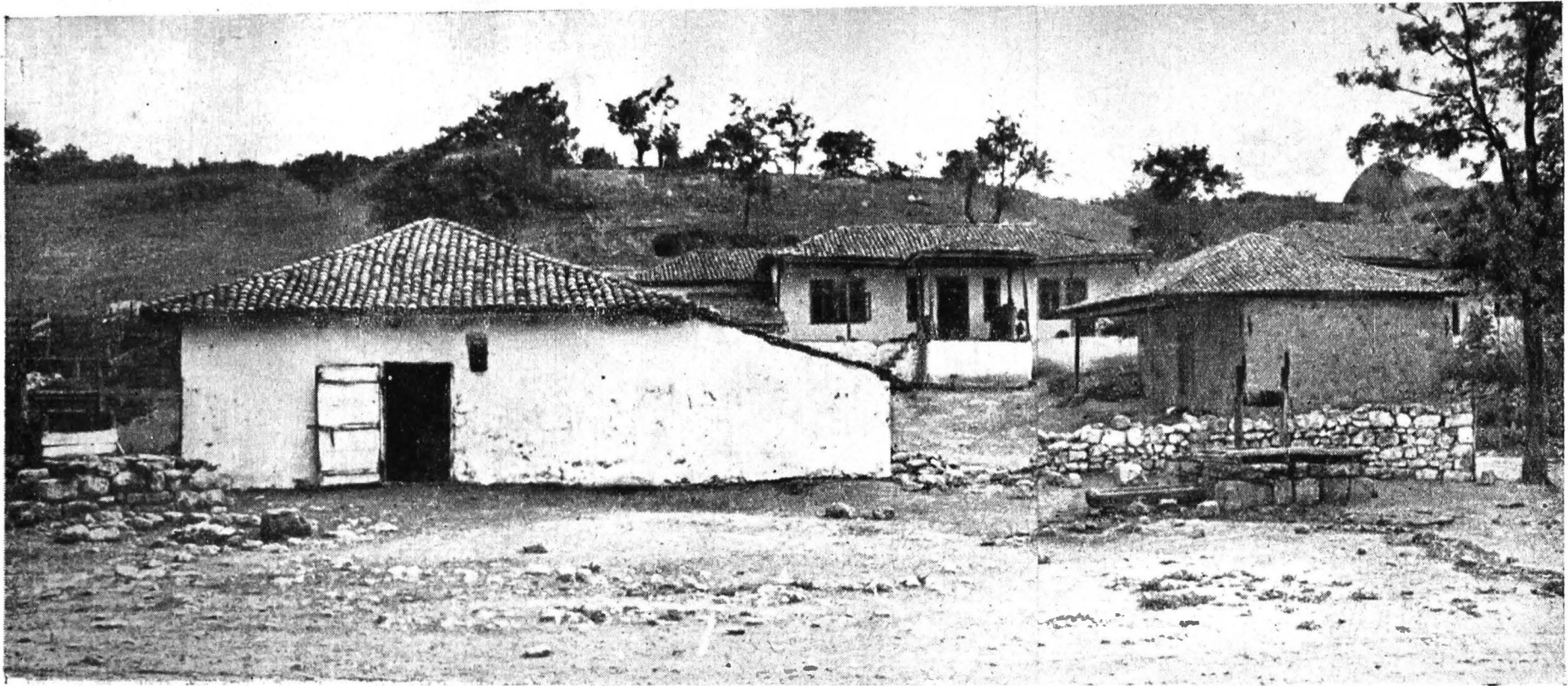
80. Cocargea. Gospodărie cu grajdul așezat în mod neobișnuit în față, cu intrarea din stradă. Locuința puțin înălțată, cu o dezvoltare în stînga, are prispă pe fațada principală și balcon, pe stîlpi de lemn, fără balustradă
