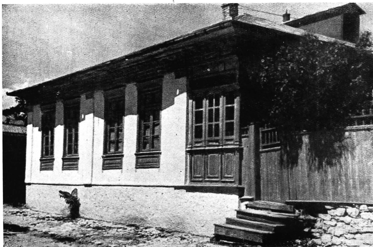
108. Jurilofca. Casă nouă cu prispa închisă spre stradă cu geamlie. Acesta ca și ancadramentele ferestrelor și friza sînt din lemn sculptat
