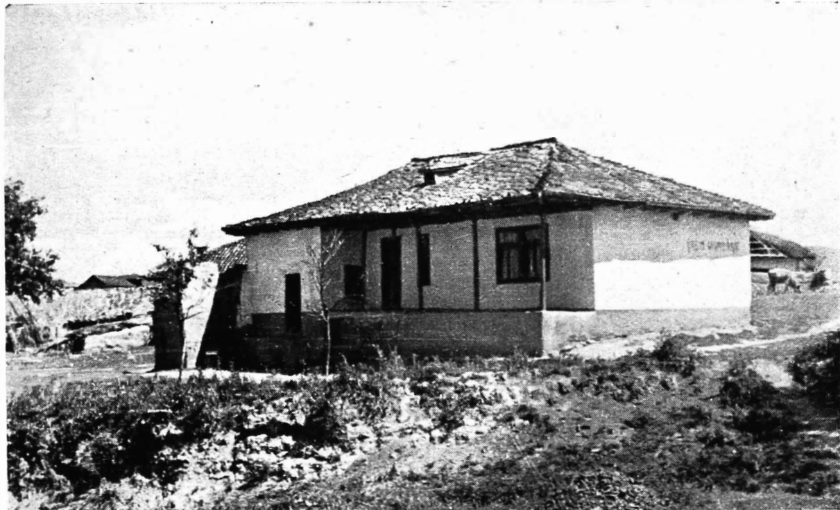
97. Cerna. Casă puțin înălțată, cu prispă parțială fără balustradă, pe stâlpi de lemn
