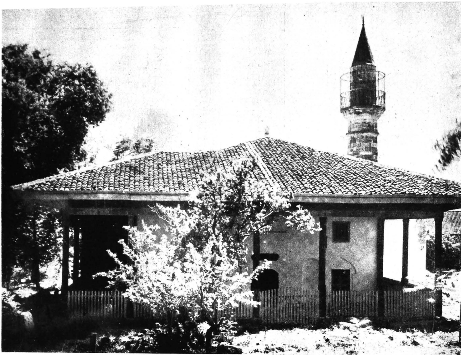
83. Mangalia. Casă veche de tip evoluat, lângă geamie, avînd pe două laturi, la nivelul solului, o prispă largă pe stîlpi înalți de lemn, cu un gîrduleț nou în locul balustradei
