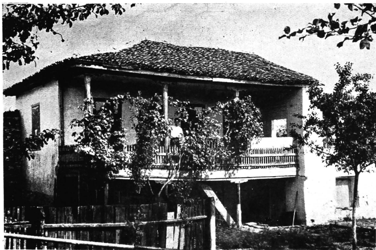
106. Babadag. Casa veche, în parte dărîmată, de lângă geamie. Prispa pe stilpi de lemn avînd sub grindă tîlpi cu tăieturi în ferăstrău, ridicată pe alți stilpi scunzi tot cu tîlpi la partea superioară. O scară repede, din lemn, urcă pe dedesubt în mijlocul prispei
