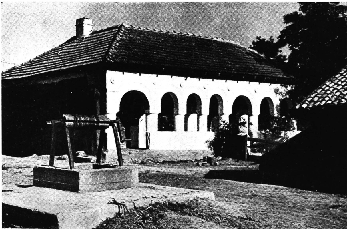
93. Ciocrlia. Casă nouă din chirpici cu prispă pe latura lungă, cu arcade supraînălțate, dintre care cele două de la intrări mai largi, pe stilpi scurți, zidiți deasupra parapetului
