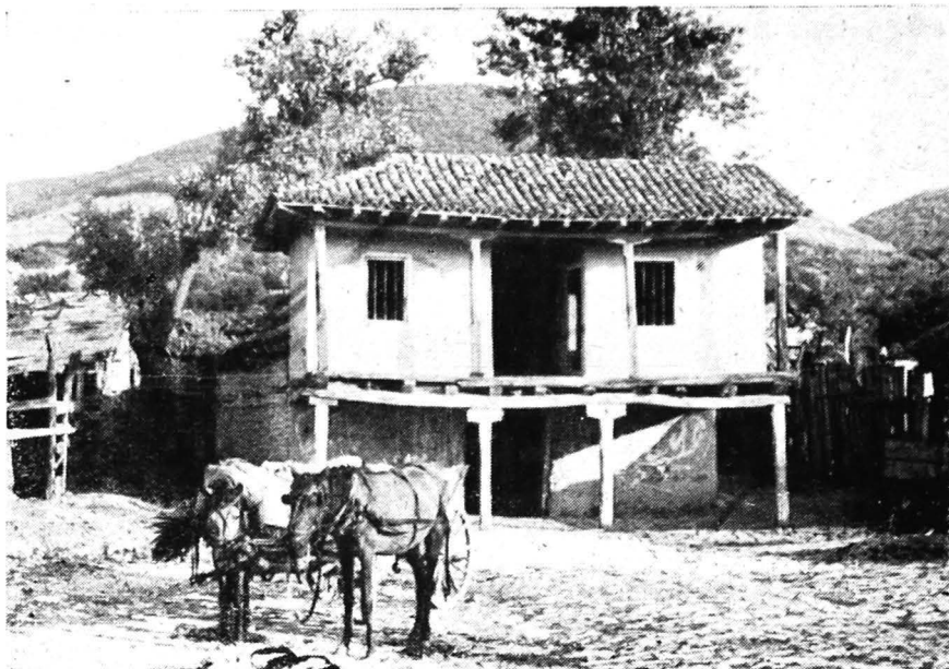
102. Babadag. Casă înălțată cu prispa pe patru stâlpi de lemn, susținută tot pe stâlpi de lemn
