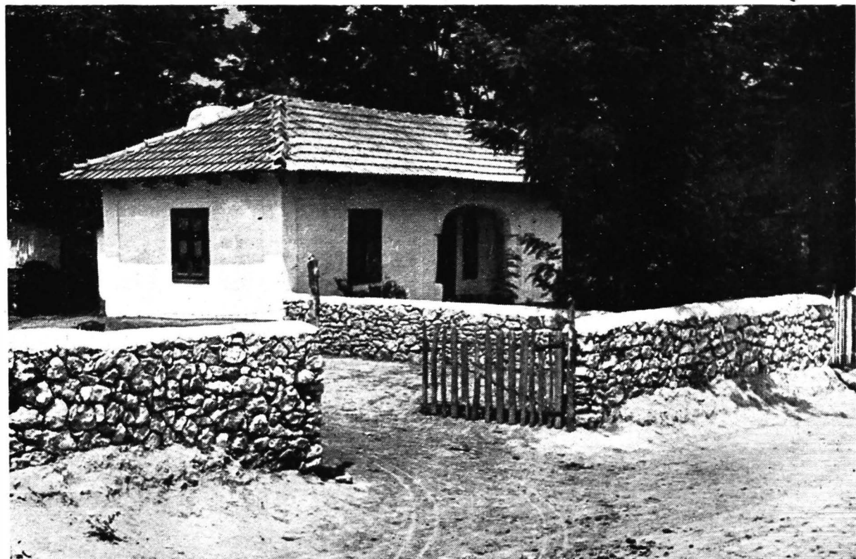
89. Crucea. Casă cu un singur arc lățit, pe doi stâlpi angajați, la prispă formată prin retragerea tindei
