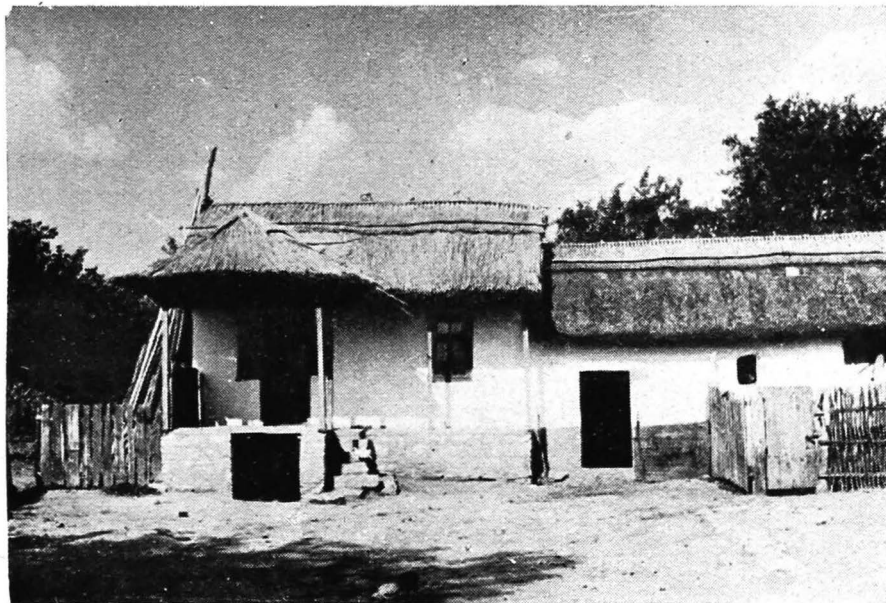
141. Babadag. Casă cu tindă și o cameră, cu grajdul în continuare. În fața prispei, peste girlici, un mic balcon acoperit în trei ape
