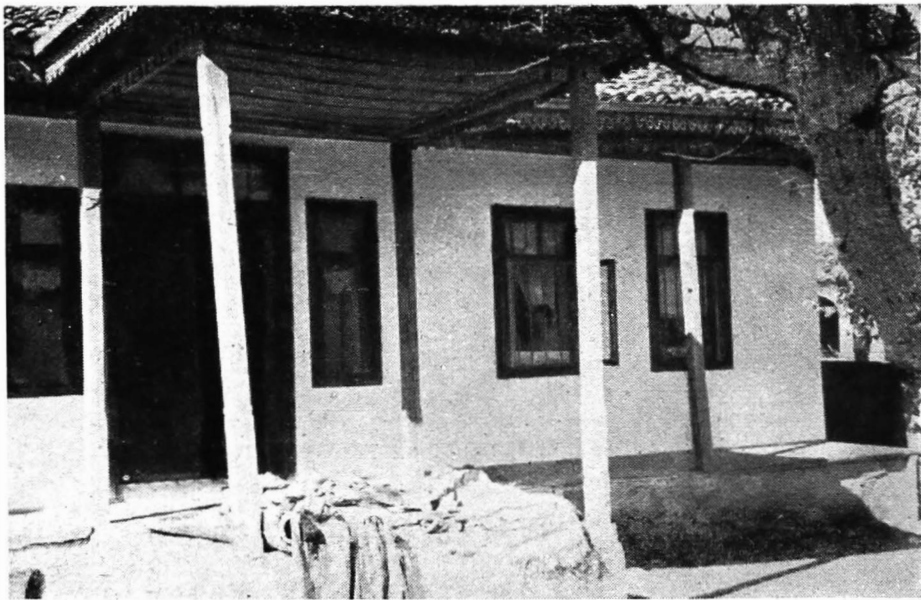
111. Ada Marinescu. Detaliu de balcon peste prispă, cu stlpi de lemn, fără balustradă
