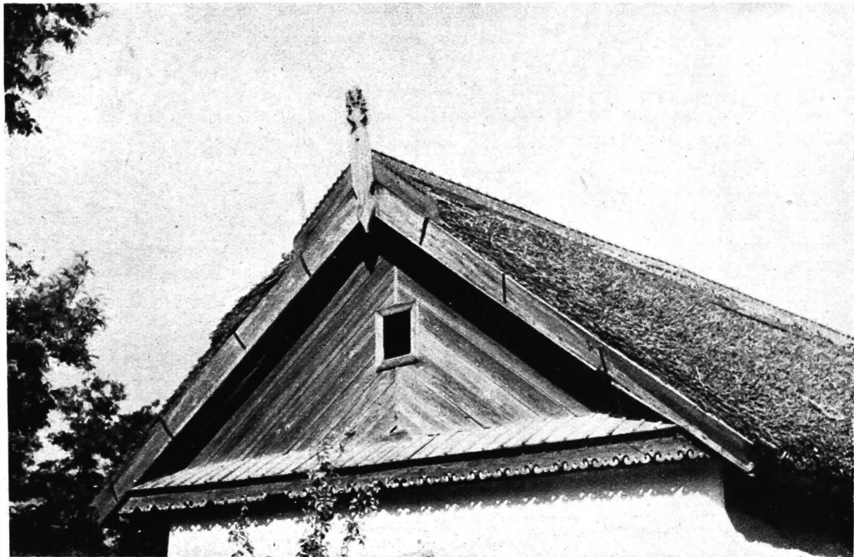
156. Mahmudia. Timpan cu o singură ferestruică dreptunghiulară și fără ornamentații. Doar săgeata din virf și pazia orizontală frumos traforate. Scindurile deasupra paziilor și coama cu tăietura în sus
