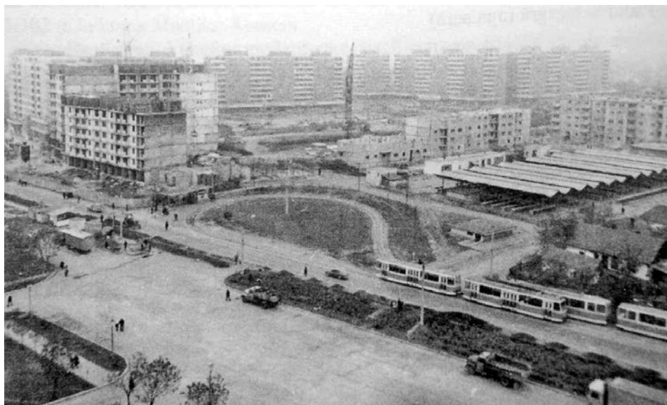
Zona pieței agro-alimentare Rogerius, aflată în reconstrucție (1979) (sursa: Nistor Ciordaș, Bihorean în vâltoarea timpului , vol. III)
