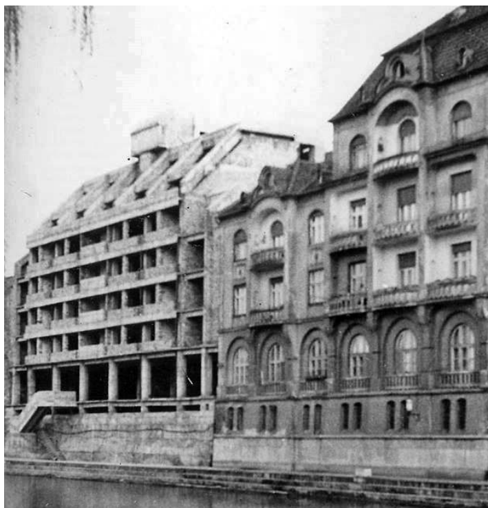
Blocul-plombă de pe malul stâng al Crișului, în 1980, în timpul construcției (sursa: Arhitectura )
