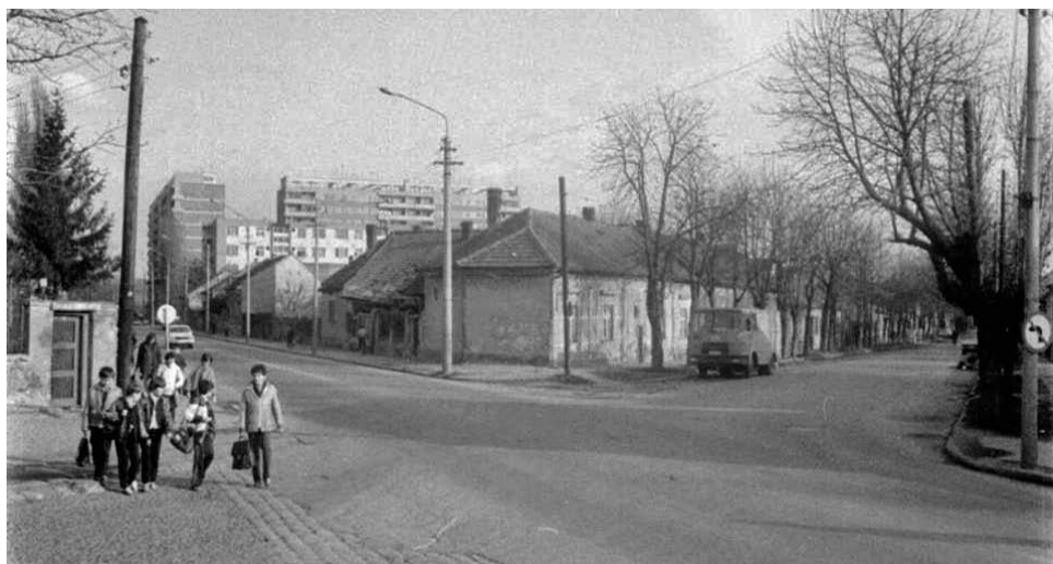
Șoseaua 6 Martie, colț cu strada Eroului Necunoscut în 1983, înaintea sistematizării – în fundal se aflau blocurile înalte construite peste drum de Palatul Baroc (foto: Darabont József)
