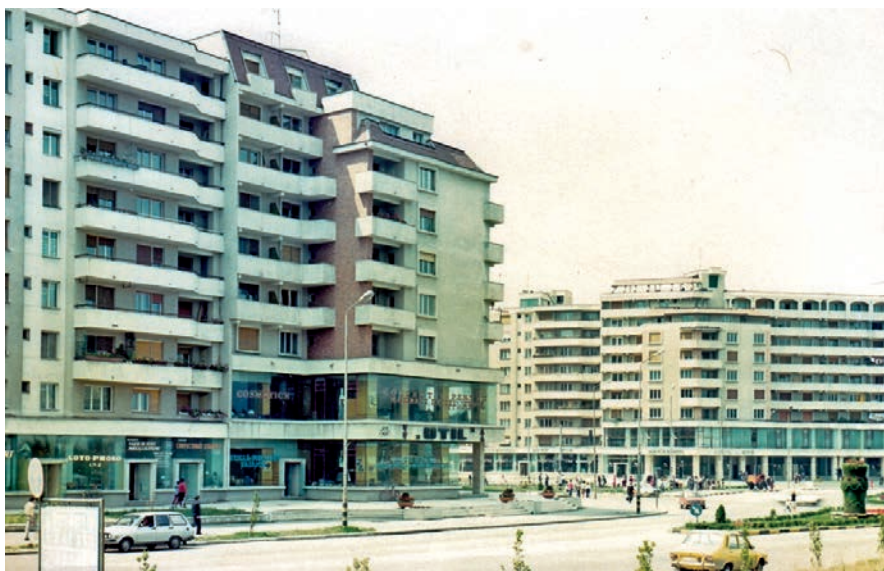
Șarpante, arcade și rulouri exterioare – soluții arhitecturale și de confort folosite foarte puțin în anii '80, aici pe Șoseaua 6 Martie (Bulevardul Dacia) (foto: T.A.G.C.M.)
