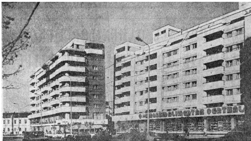
1986: blocurile de pe bulevardul Magheru erau predate noilor locatari (sursa: Crișana )
