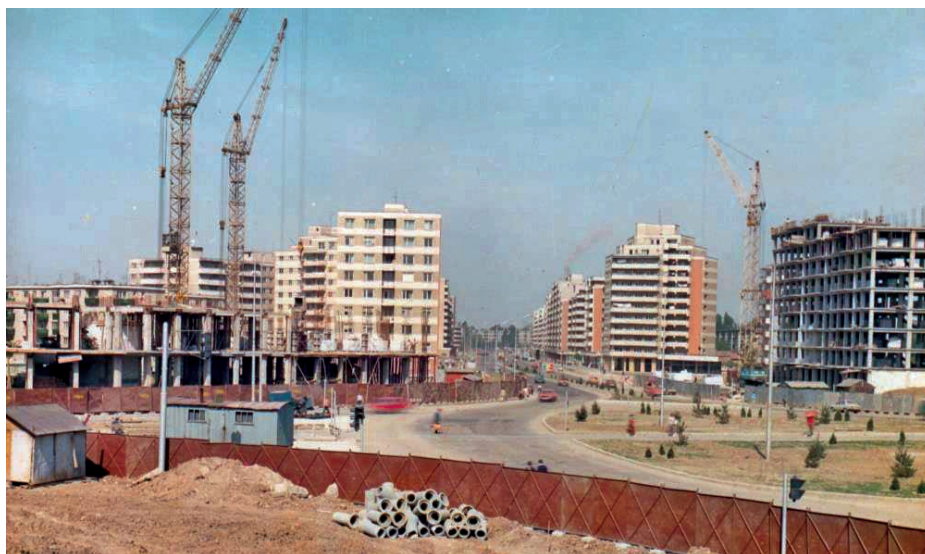
1986: intersecția Șoselei 6 Martie (Bulevardul Dacia) cu Bulevardul Decebal, în șantier (foto: T.A.G.C.M.)
