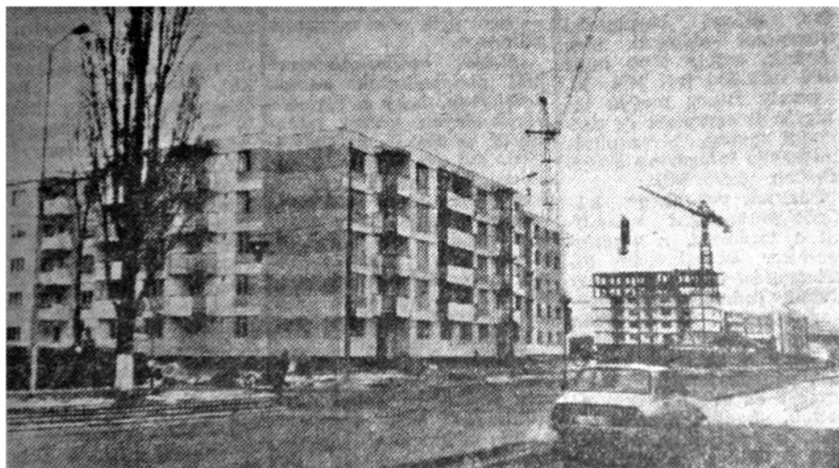
Se construiau blocurile de pe bulevardul D. Cantemir (1988) (sursa: Fáklya )
