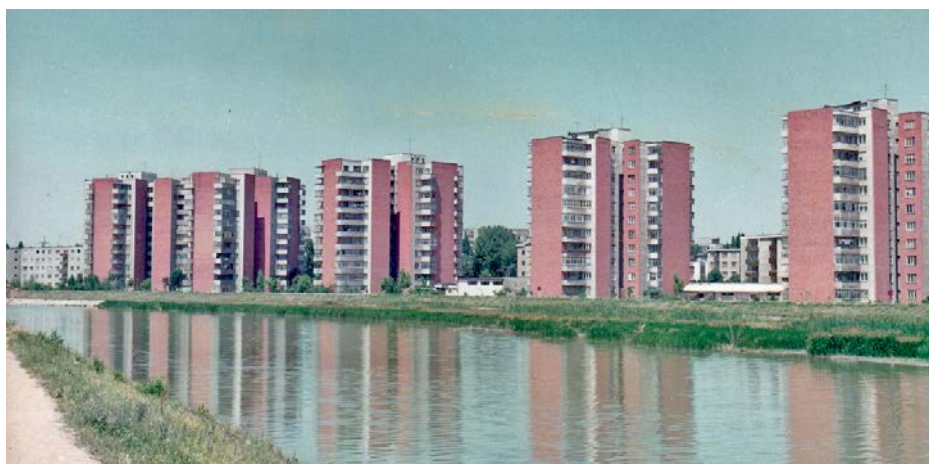
Blocurile C proiectate de Emilia Abrudeanu și construite în anii '70 (foto: T.A.G.C.M.)
