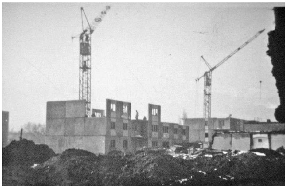
1986: blocuri din elemente prefabricate, în construcție pe strada Vasile Conta
