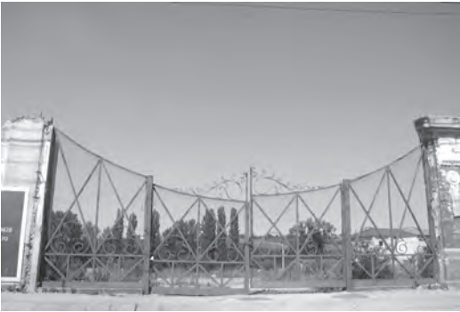
Fig. 2. Portalul de intrare în fosta fabrică de spirt (copie fidelă a originalului). Este tot ceea ce a mai rămas în urma demolării fabricii, în 2007. Starea sa de conservare este satisfăcătoare, bunul cultural având valoare istorică, ceea ce o predestinează prezervării.
