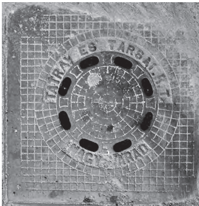
Fig. 1. Capac din fontă destinat gurilor de canal. Produsul, obținut prin turnare, poartă emblema Turnătoriei și fabricii de mașini „Tátray și Asociații” S.A. din Oradea. Două asemenea capace se găsesc montate pe guri de canal din interiorul zidurilor Fortăreței orădene, în nemijlocita apropiere a accesului spre Facultatea de Arte Vizuale .
