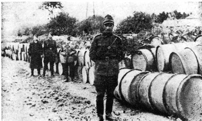
Depozit de carburanți pe front
