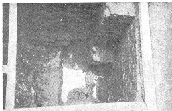
Fig. 46. — Incăpere lângă zidul din str. Soarelui Nr. 7. Talpa zidului, bârnă de stejar carbonizat și nivelul apei.
