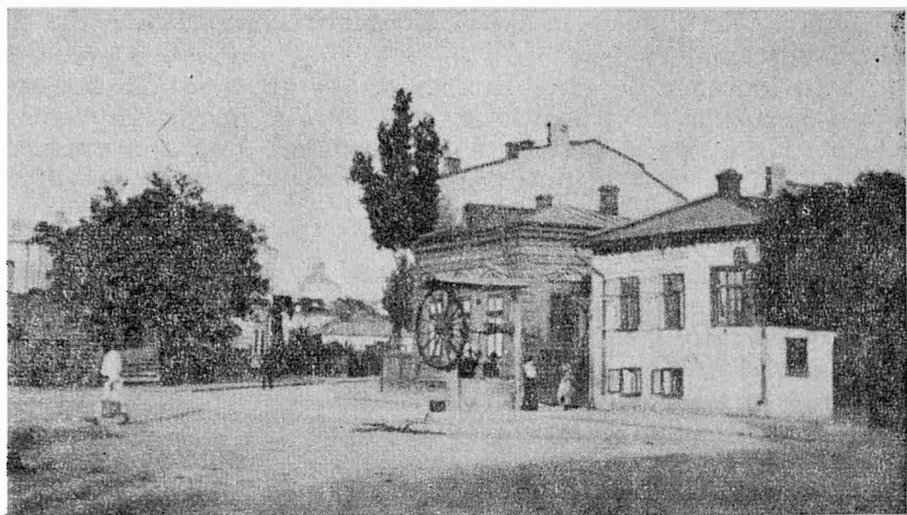
Puțul cu zale din strada Antim
