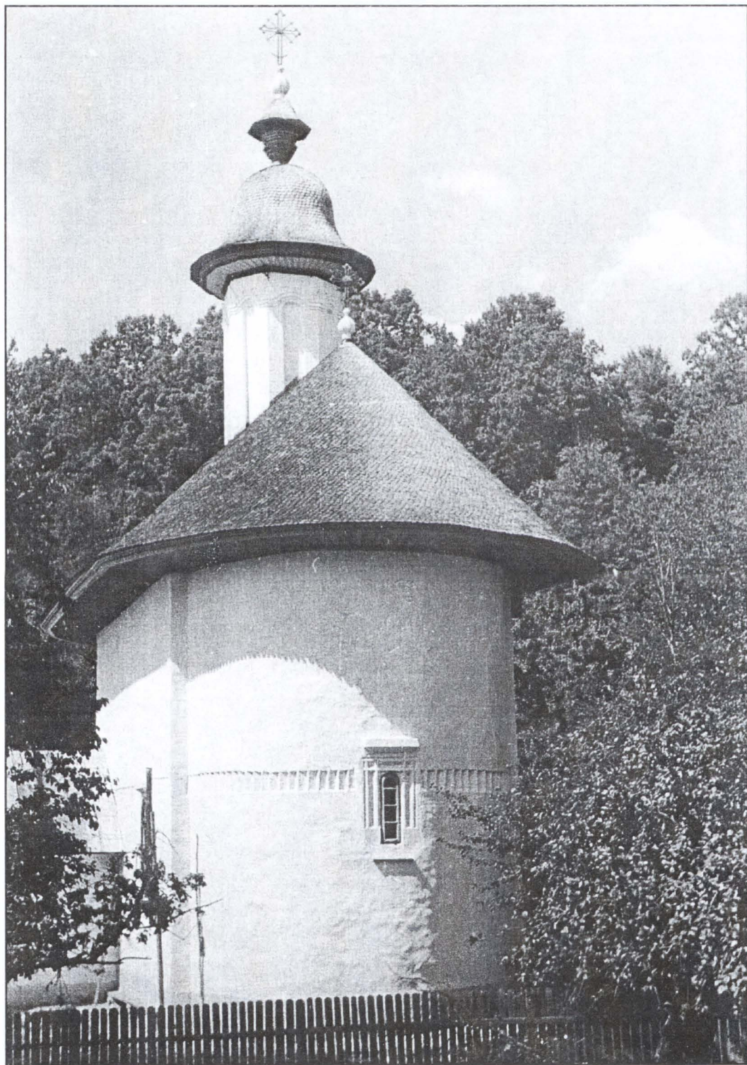
Fig. 152. Biserica din Buhalnița - vedere dinspre sud-est.
