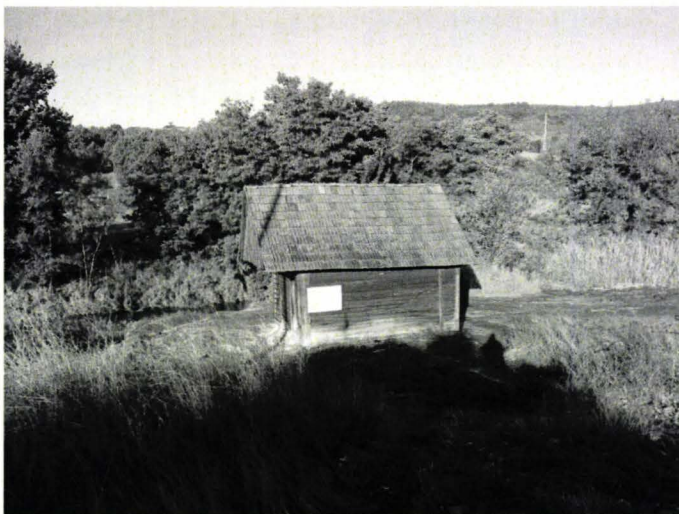
Corund – Fântână cu apă sărată acoperită de o „căsuță” de lemn
