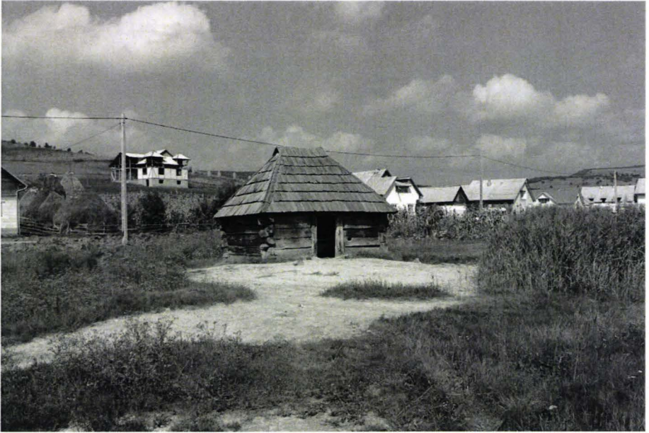
Cepari – Fântâna cu apă sărată acoperită de o „căsuță” de lemn.
